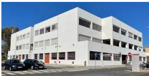
Figura 17 – Edifício do caso de estudo [27]
