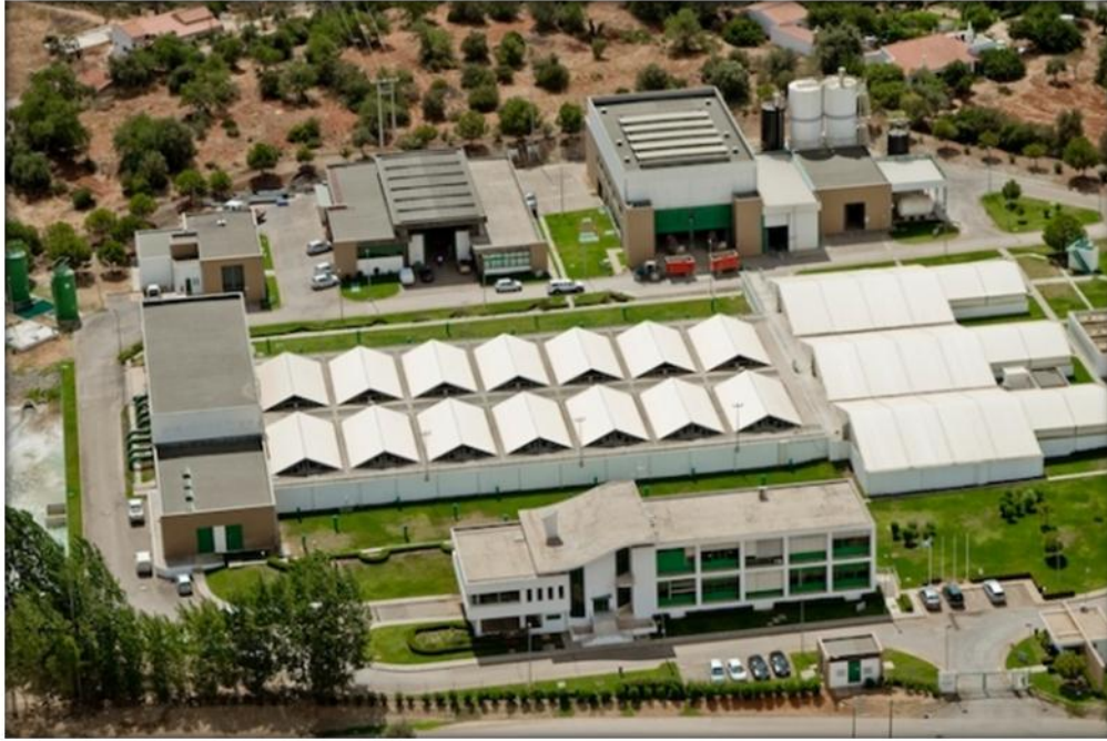
Figura 18 - Estação de Tratamento de Águas de Alcantarilha
