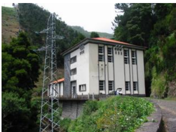
Figura 5 - Central hidroelétrica da Calheta I
