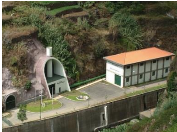
Figura 7 - Central hidroelétrica dos Socorridos
