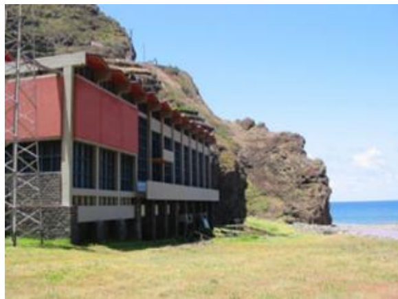
Figura 9 - Central hidroelétrica da Ribeira da Janela
