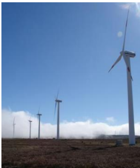
Figura 16 - Parque eólico do Paul da Serra (ENEREEM)
