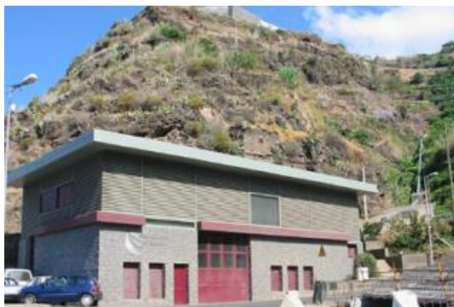
Figura 6 - Central hidroelétrica da Calheta II
