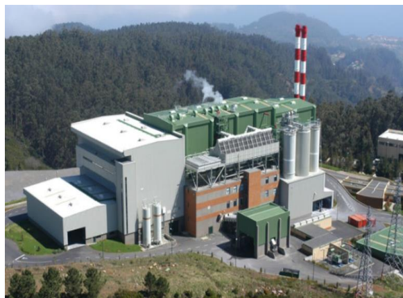
Figura 21 - Estação de Tratamento de Resíduos Sólidos Urbanos
