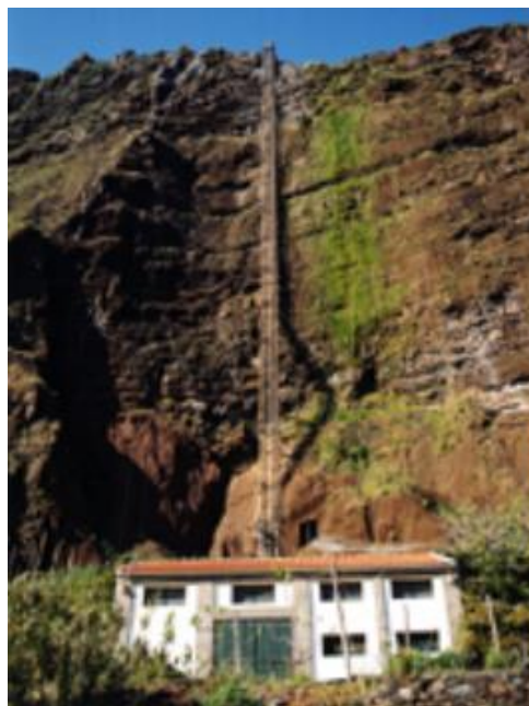
Figura 11 - Central hidroelétrica da Fajã dos Padres
