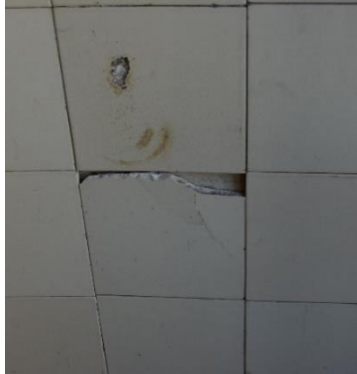
Figura 32 - Azulejo fraturado
