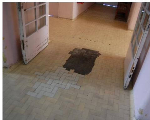
Figura 17 - Pavimento degradado
