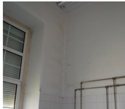
Figura 31 - Manchas de humidade
