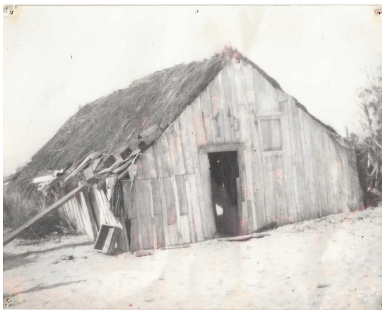
Figura 3. Casa de junco e madeira, Arquivo Associação de moradores da Ilha da Culatra
