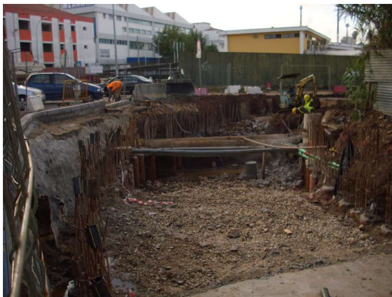
Fig. 35 Troço 4 – Infraestruturas existentes, já com a execução das estacas
