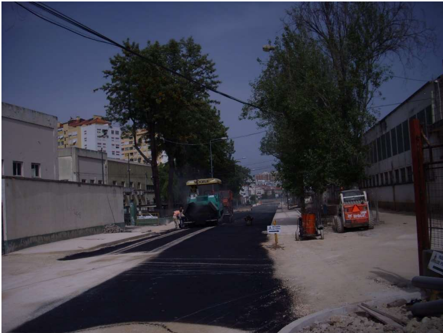
Fig. 57 Camada de Regularização
