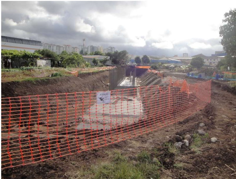
Fig. 29 Troço realizado a céu aberto
