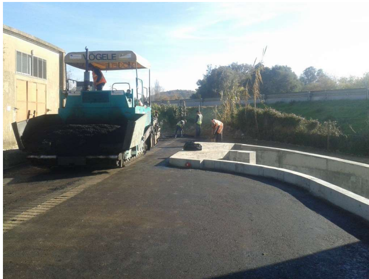
Fig. 62 Espalhadora acabadora para asfalto
