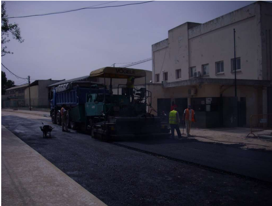
Fig. 58 Camada de Regularização
