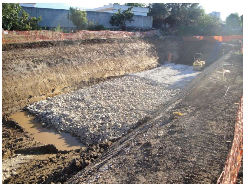
Fig. 5 Substituição dos solos na fundação no Troço 6
