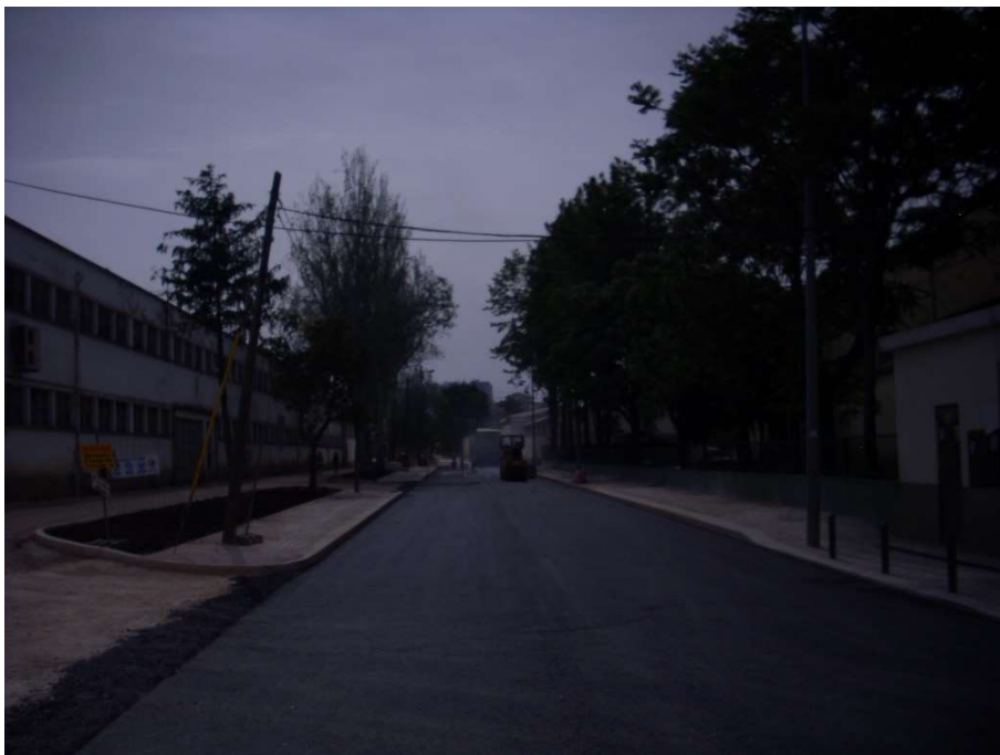
Fig. 59 Cama de Desgaste em Betão Betuminoso
