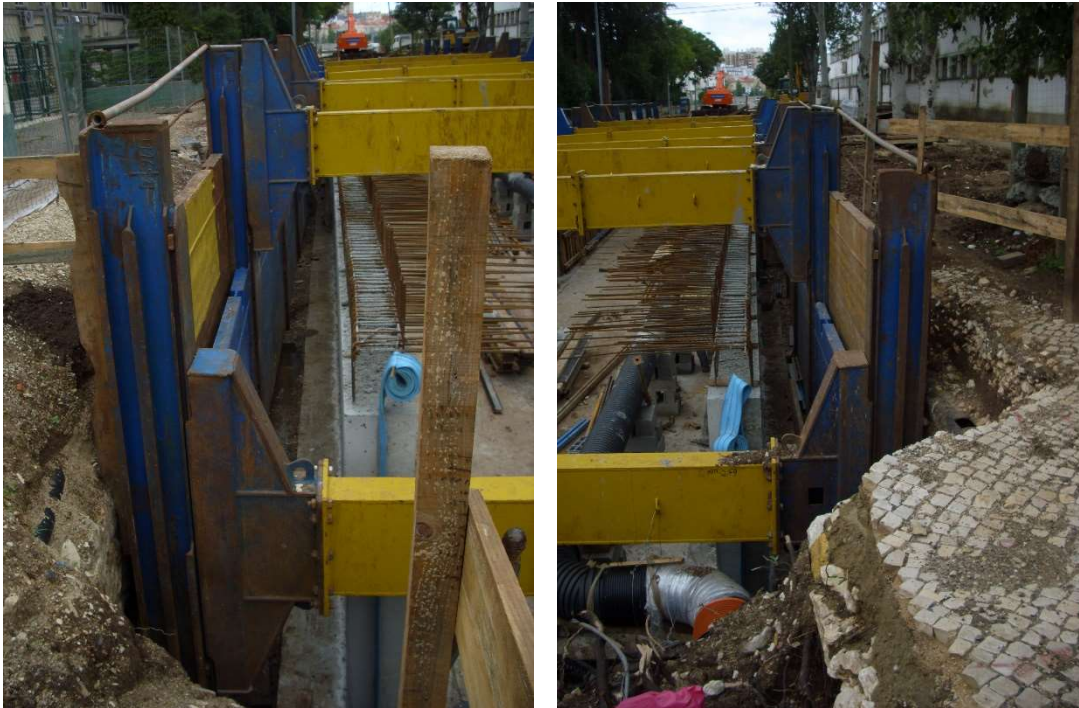
Fig. 32 a e 32b Troço 1 e 2 Entivação pesada SHB, para escavação a céu aberto para execução da estrutura com colocação da junta de dilatação nas paredes
