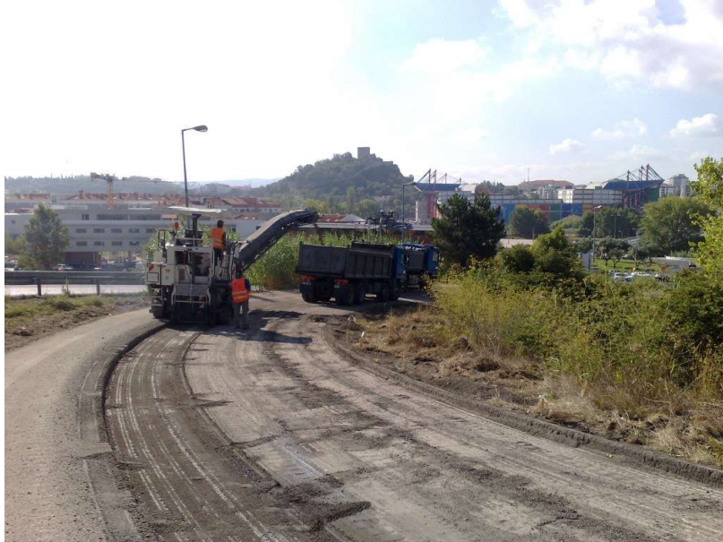
Fig. 65 Fresadora de asfalto
