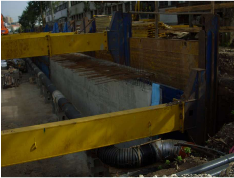
Fig. 51 Desvio provisório das águas residuais domésticas
