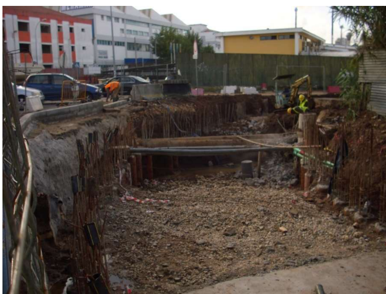
Fig. 21 Troço quatro – processo invertido
