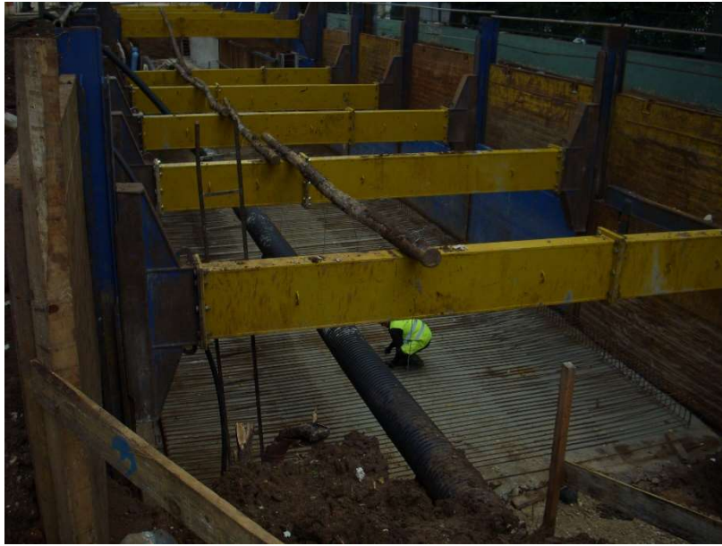
Fig. 17 Lajes de fundo na rua do estaleiro Edifer / Tecnasol
