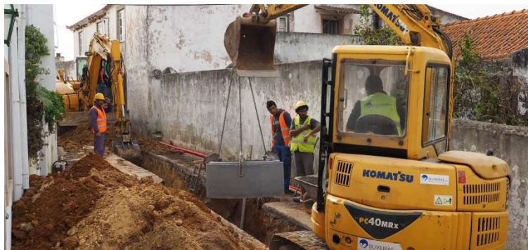
Fig. 68 Mini giratória de 4 toneladas
