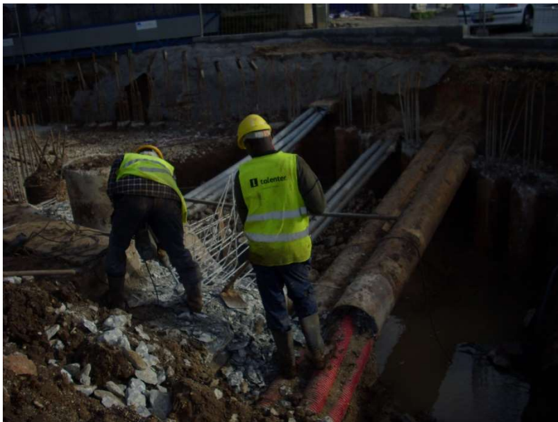
Fig. 52 Eletricidade Alta, média e baixa tensão
