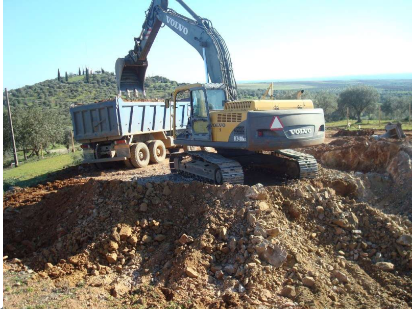
Fig. 61 Giratória 24 toneladas + camião de três eixos
