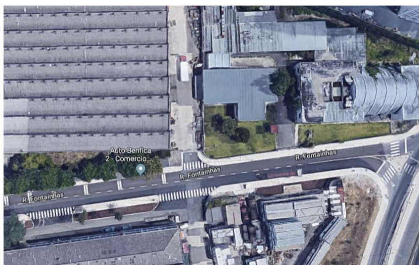
Fig. 28 Vias de acesso repostas
