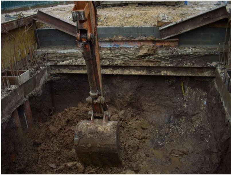
Fig. 23 Escavação para o acesso ao troço três e quatro realizado por processo invertido
