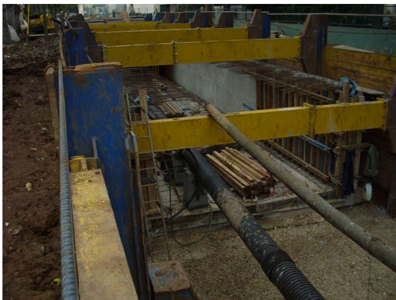
Fig. 19 Troço dois a vala aberta
