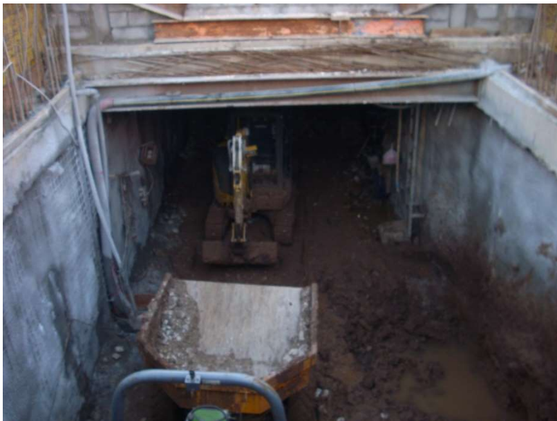
Fig. 24 Escavação dentro do troço três e quatro
