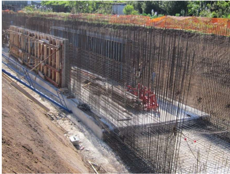
Fig. 39 Execução das armaduras nas paredes do troço seis
