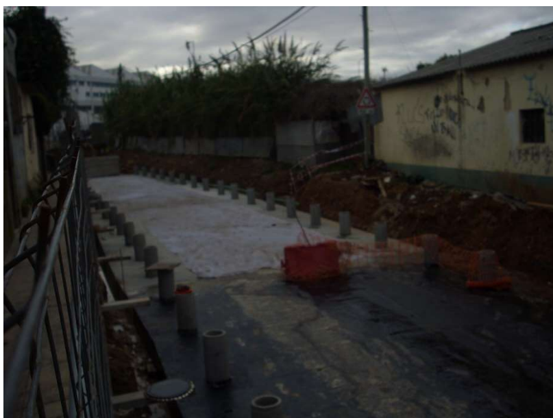
Fig. 33 Troço 5 Escavação mineira
