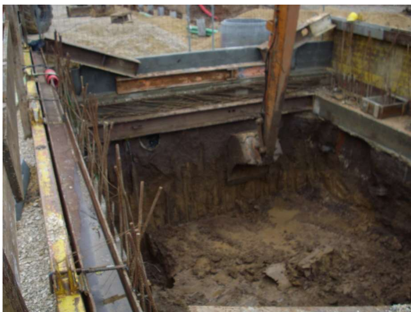
Fig. 50 Execução do negativo para criar acessos
