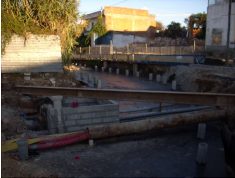
Fig. 36 Troço 4 – Infraestruturas existentes protegidas, e com a laje superior já executada
