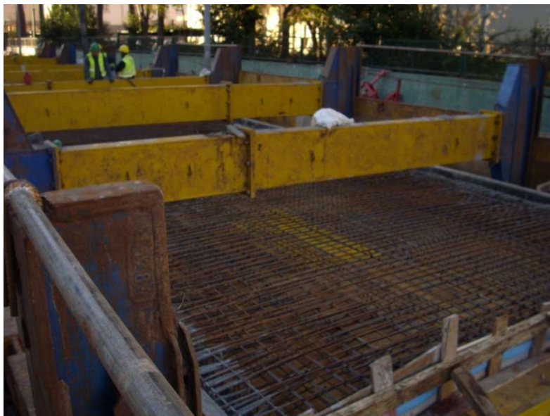
Fig. 22 Troço cinco – realizado com entivação pesada a céu aberto
