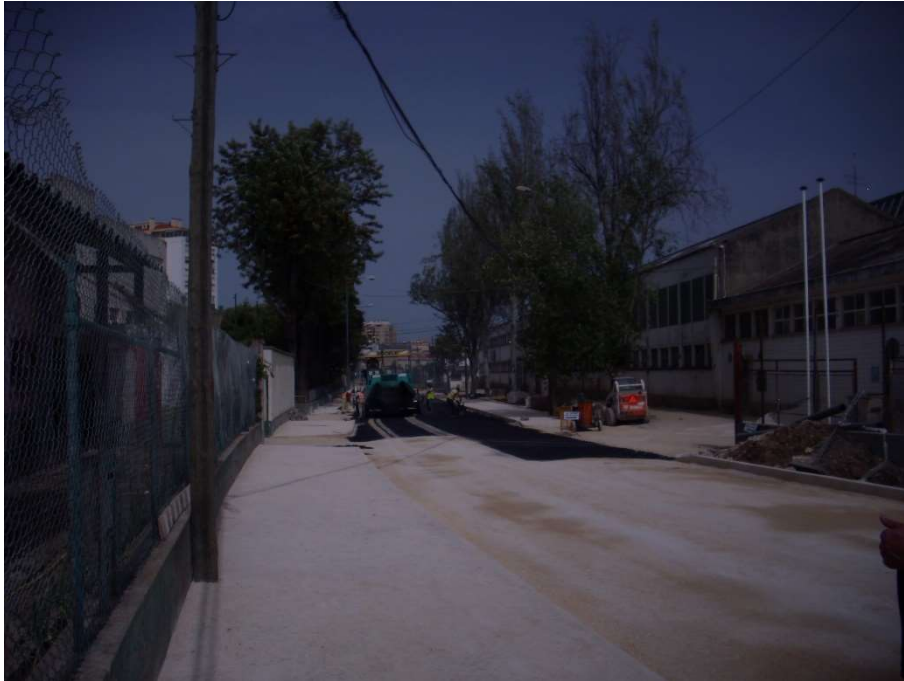
Fig. 56 Execução dos Passeios e Colocação da Base em Agregado de Granulometria Contínua
