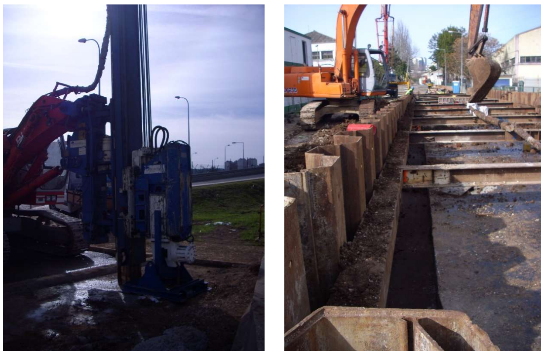
Fig. 16a e 16b Máquina de cravar estacas prancha e cortina de estacas prancha, junto ao estaleiro Edifer / Tecnasol
