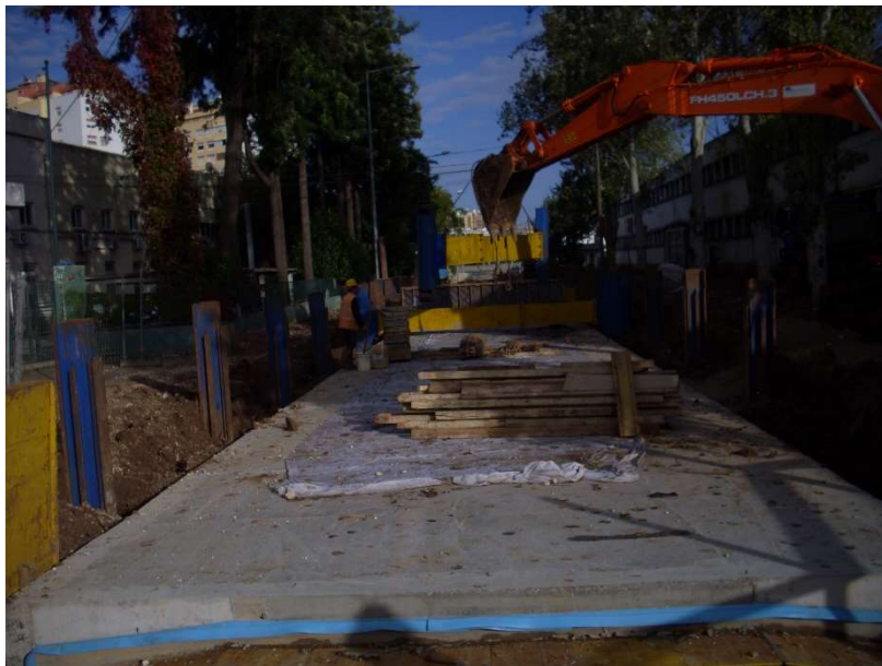
Fig. 18 Remoção da estrutura de entivação na rua do estaleiro Edifer / Tecnasol
