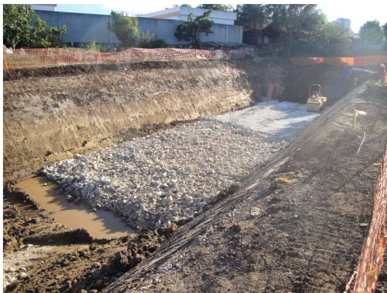
Fig. 40 Substituição dos solos de fundação
