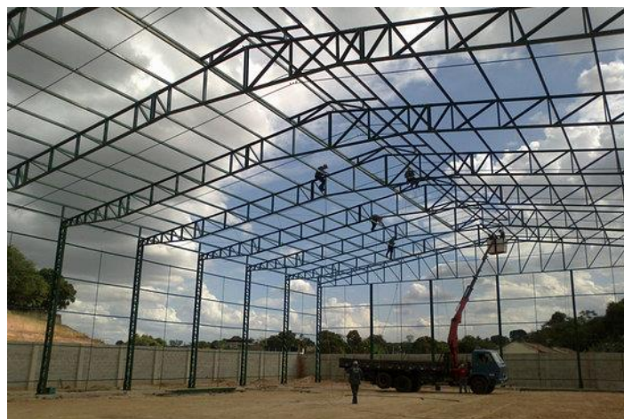
Figura 1.2 - Pavilhão industrial em fase de montagem
