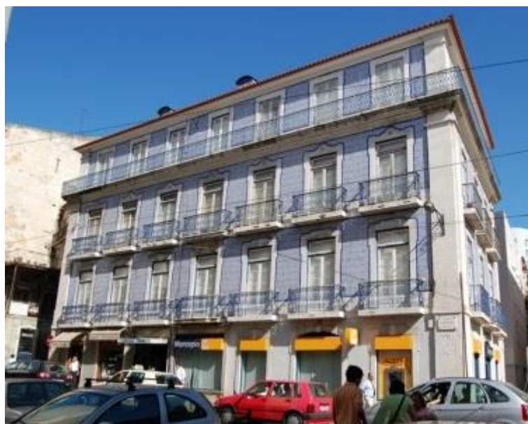
Figura 2.5 Edifício pombalino localizado na calçada Marquês de Abrantes, em Lisboa (ADN, 2013)
