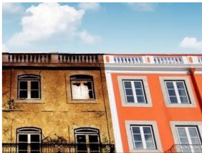
Figura 2.27 Exemplo de uma reabilitação ligeira num edifício de Faro (A-Sul, 2011)
