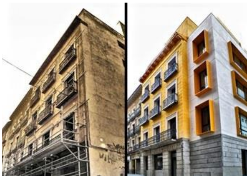
Figura 2.1 Edifício reabilitado (Trindade, 2012)
