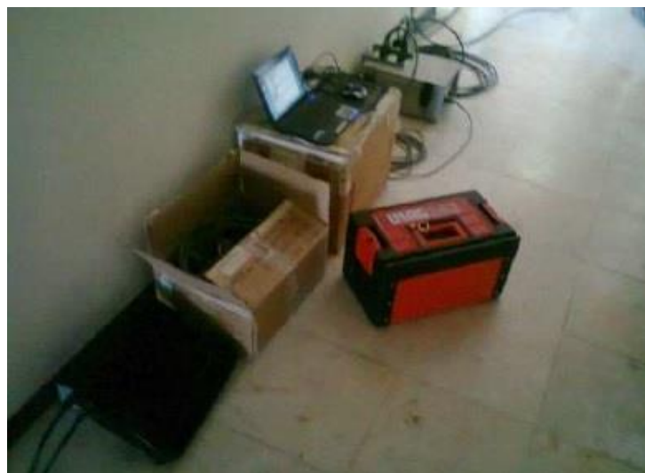
Figura 4.10 Sistema de aquisição de dados instalado (Mendes, 2012b)
