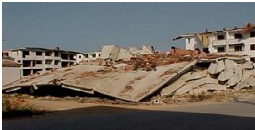
Figura 2.32 Ruína de um edifício por provável ausência de efeito de pórtico (Vaz, 2013)
