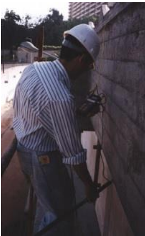
Figura 2.17 Medição dos potenciais eléctricos em obra (Cóias, 2009)
