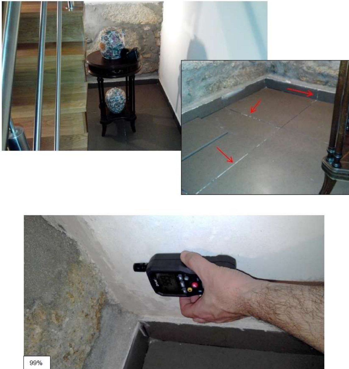
Figura 32 - Piso de cave sob o vão de escadas (2)
