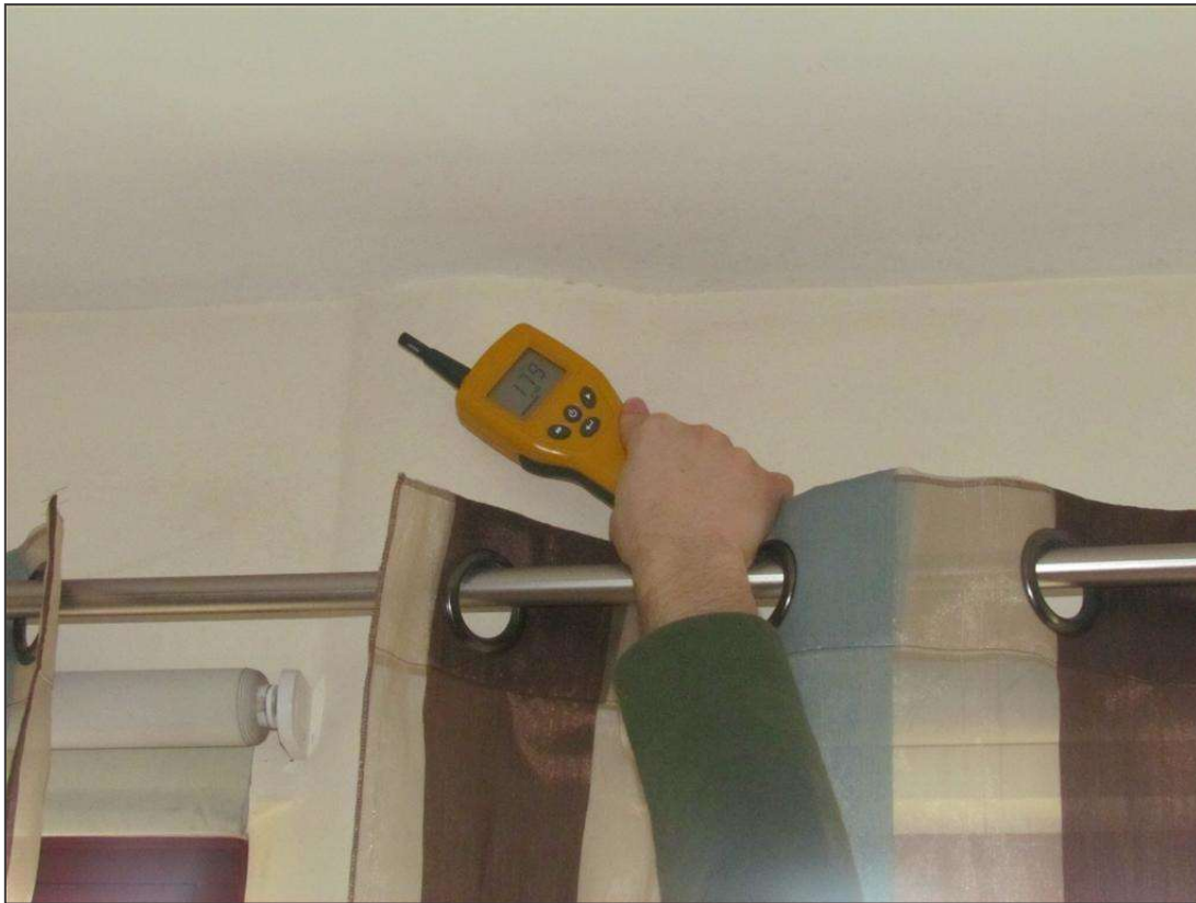
Figura 111 - Medição de teor de humidade na parede, superfície seca
