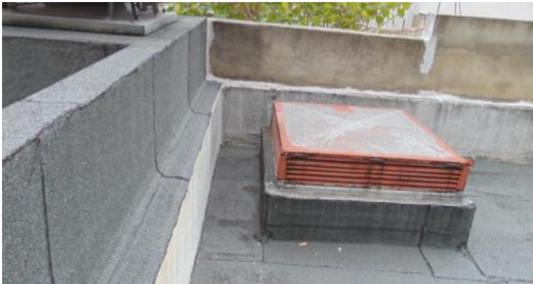
Figura 1-Impermeabilização do terraço
