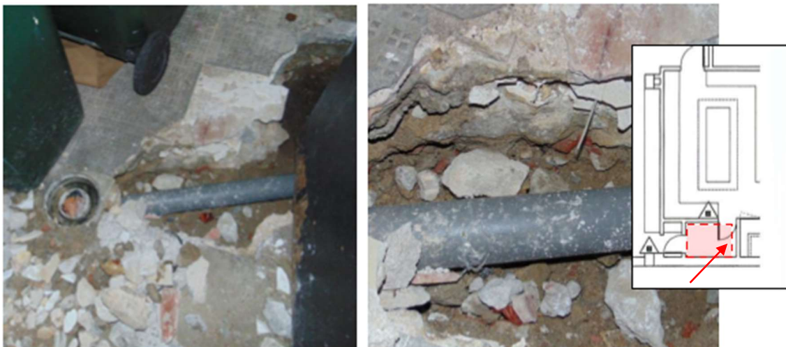
Figura 22 – Intervenção em canalização de esgoto, Cozinha
