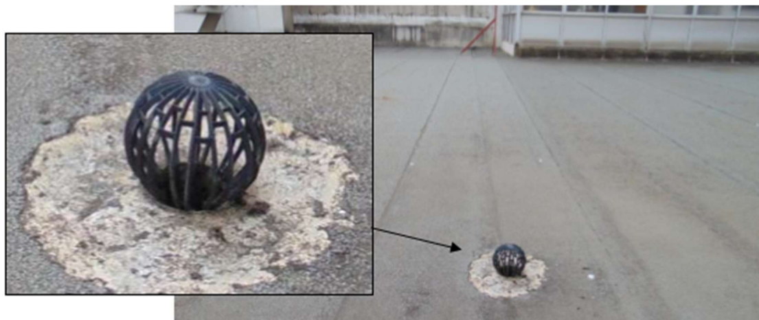
Figura 25 – Ralo de drenagem, Terraço
