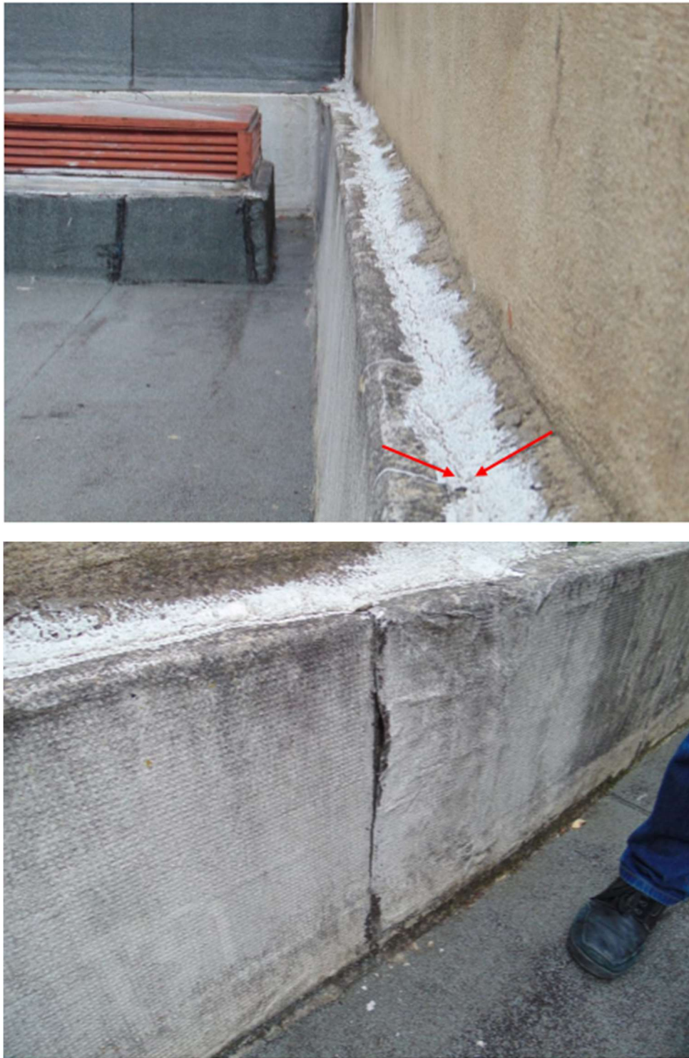
Figura 28 – Muro de terraço, Este
