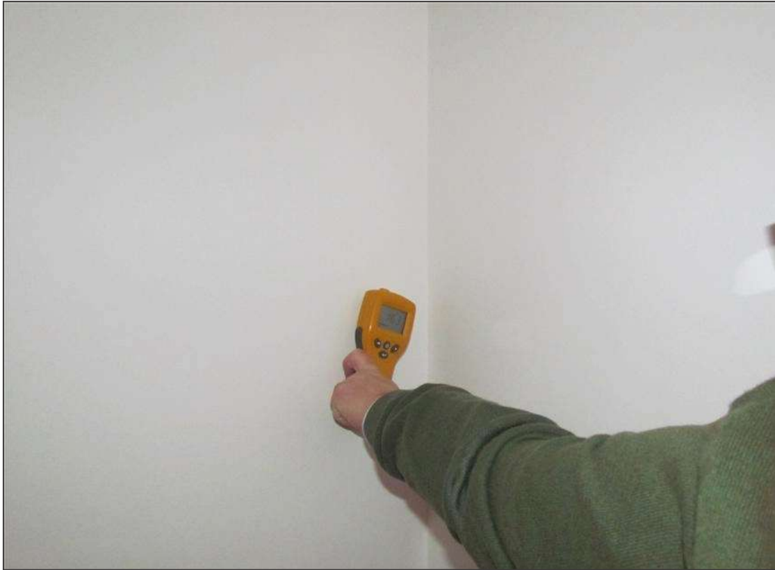
Figura 113 - Medição de teor de humidade na parede, superfície seca
