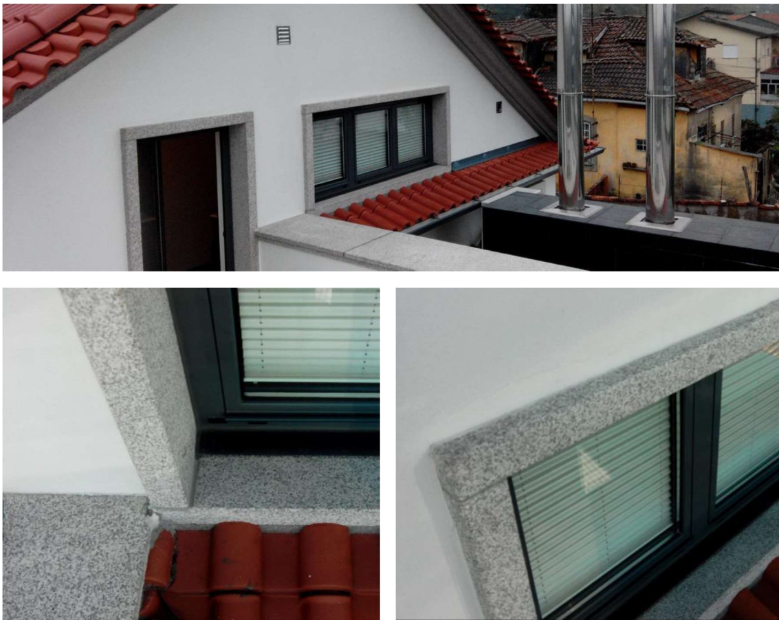
Figura 46- Vão de Janela virado a tardoz (local 2)
