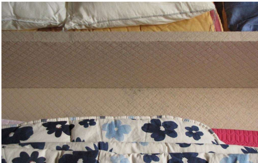
Figura 81 – Presença de bolores em arrumos sob a cama.
