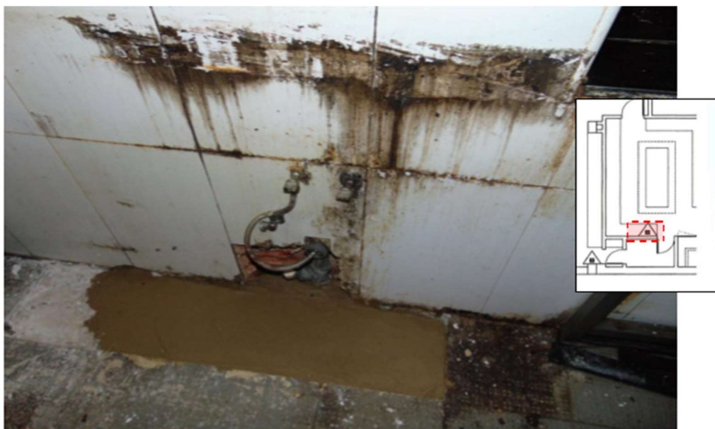
Figura 23 – Intervenção em canalização de esgoto, Cozinha
