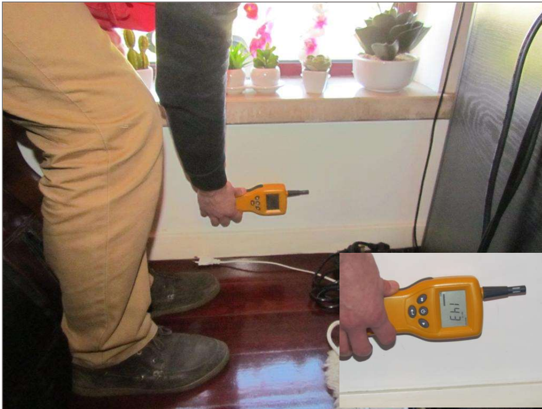
Figura 97 - Medição de teor de humidade na parede, superfície seca
