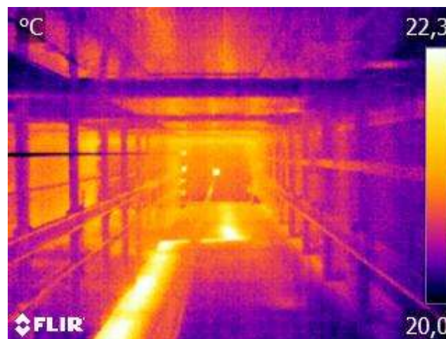
Figura 12- Conduta, no interior da caixa do elevador.
