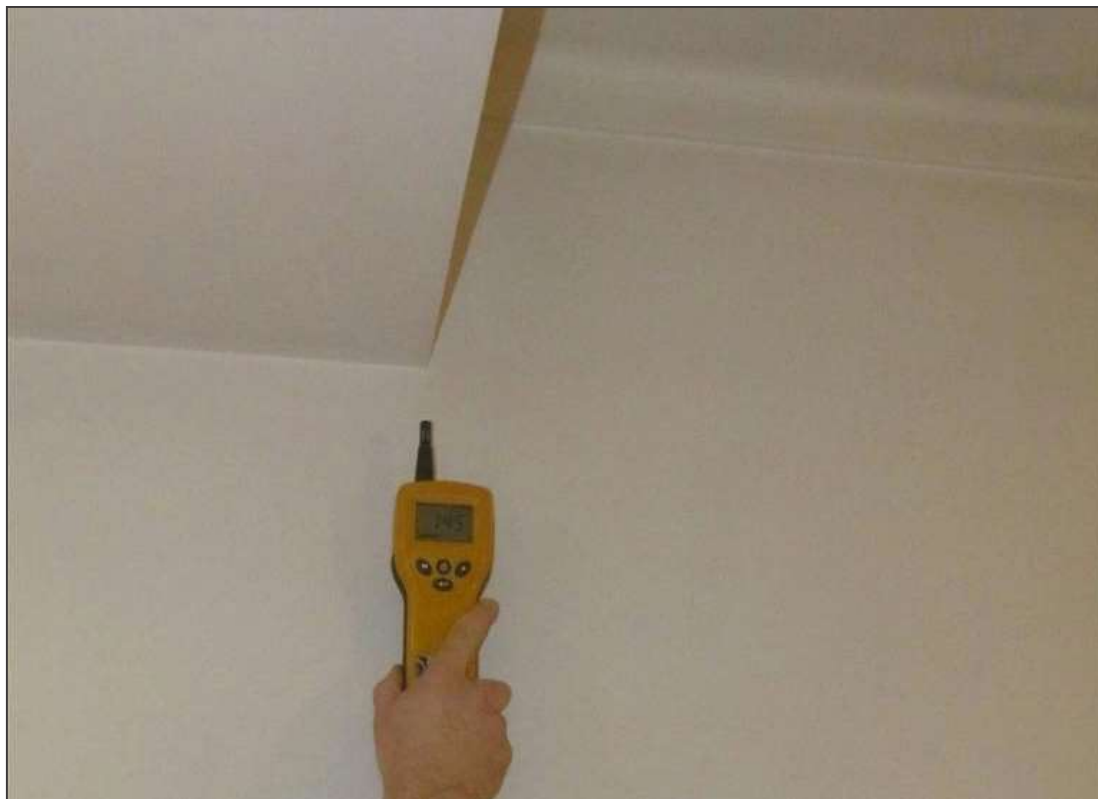
Figura 103 – Medição de teor de humidade na parede, superfície seca
