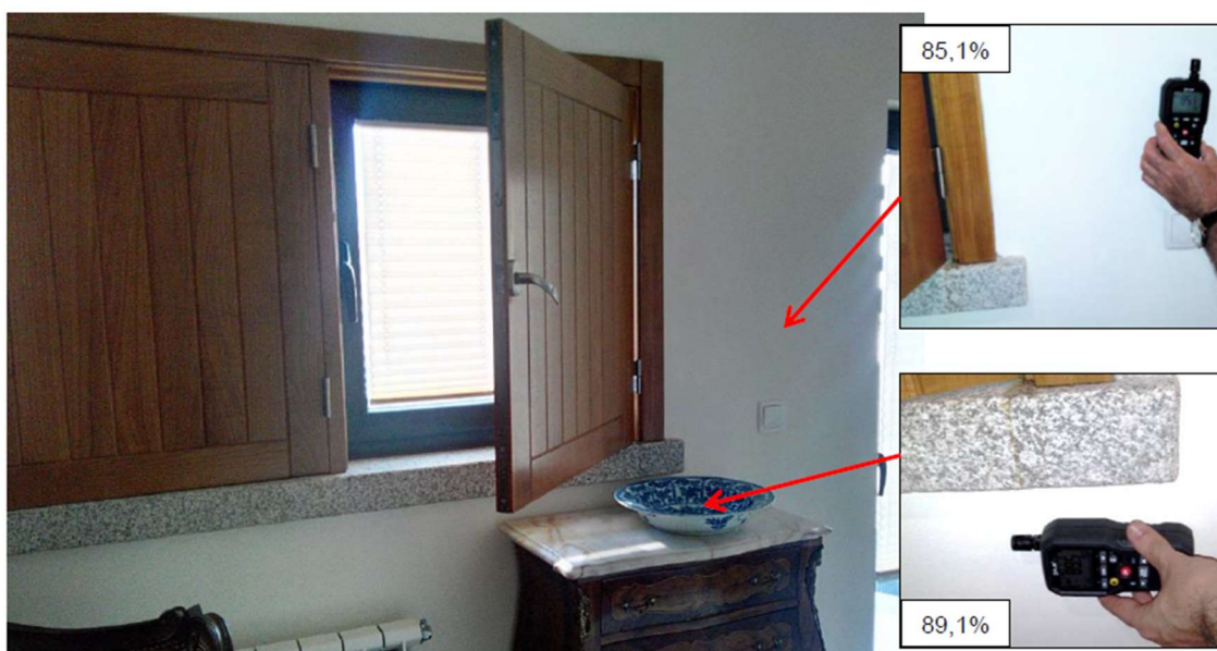
Figura 45 - Medição do teor de humidade em janela (local 2)
