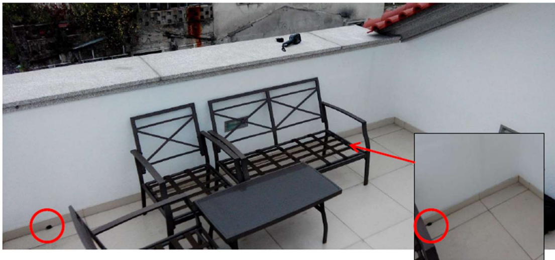
Figura 44 - Drenagem do terraço (local 1)
