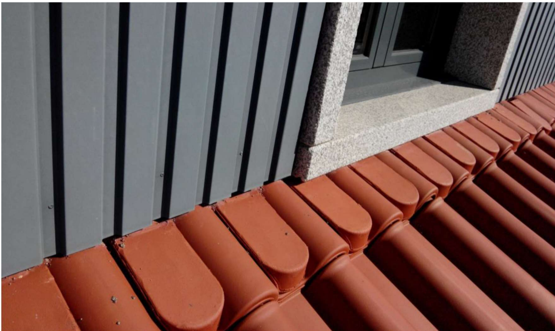
Figura 49- Vão de janela (local 3)
