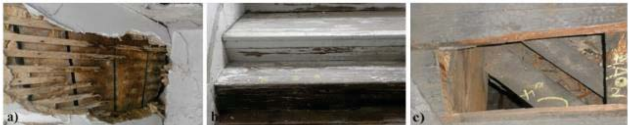
Figura 97 - a) Costaneira; b) Escada; c) Viga do pavimento
