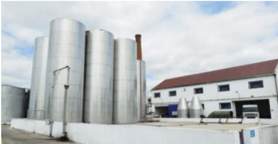
Figura 5 – Depósitos de armazenamento do produto final
