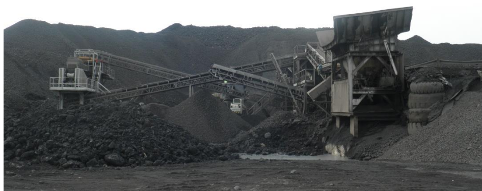
Figura 7 - MRP (Metal Recovery Plant) nas instalações da HARSCO na SN do Seixal
