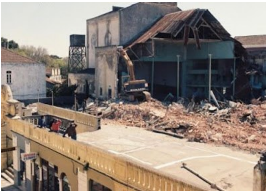
Figura 2.4 - Demolição do Antigo Parque Cine
