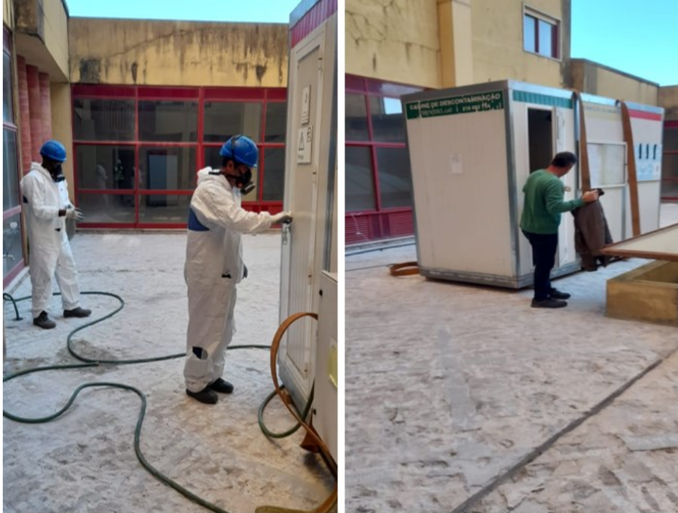
Figura 2.33 - Descontaminação de Trabalhadores da remoção de Fibrocimento
