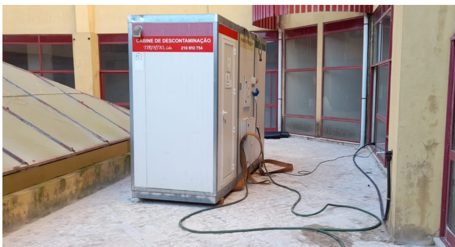
Figura 2.32 - Cabine de Descontaminação
