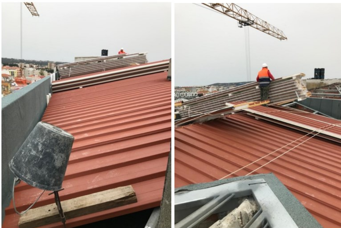
Figura 2.35 - Montagem dos Painéis Sandwich na Cobertura
