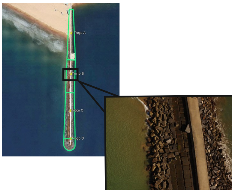
Figura 4.10 – Aumento da largura da berma do coroamento exterior do troço B do Quebra-mar Poente de Portimão
