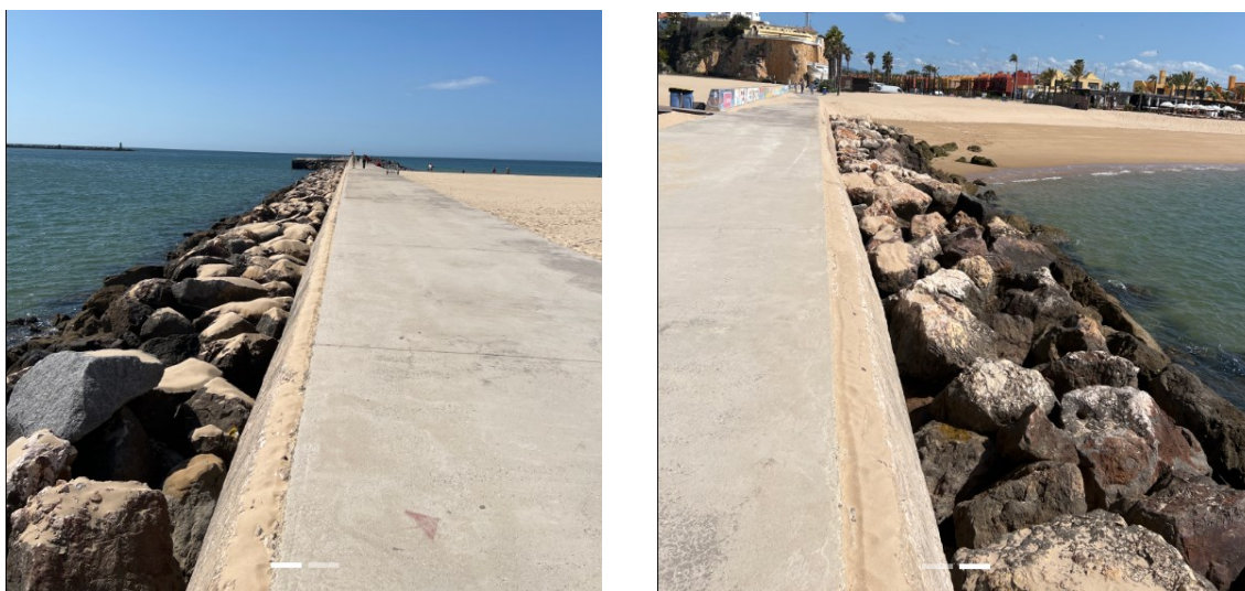
Figura 4.3 – Troço A (ponto 1, talude interior e coroamento). Esquerda) vista sentido da cabeça; Direita) vista sentido do enraizamento
