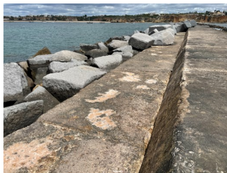
Figura 5.7 – Comparação de registo fotográfico em Portimão nascente, ponto 15, vista sentido do enraizamento. Em cima: esquerda) LNEC 2022, direita) Signatário 2022. Em baixo: LNEC 2020
