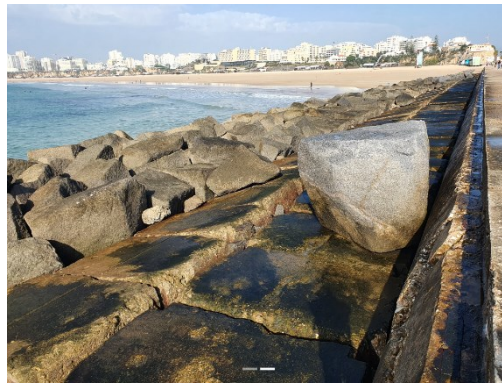
Figura 5.8 – Comparação de registo fotográfico em Portimão poente, ponto 9, vista sentido do enraizamento. Em cima: esquerda) LNEC 2022, direita) Signatário 2022. Em baixo: LNEC 2020
