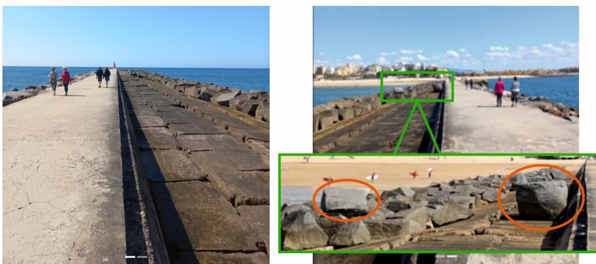
Figura 4.7 – Troço B (ponto 11, talude exterior e coroamento). Esquerda) vista sentido da cabeça; Direita) vista sentido enraizamento
