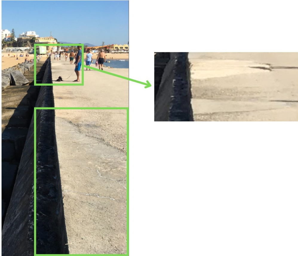
Figura 4.8 – Reparações efetuadas no passadiço
