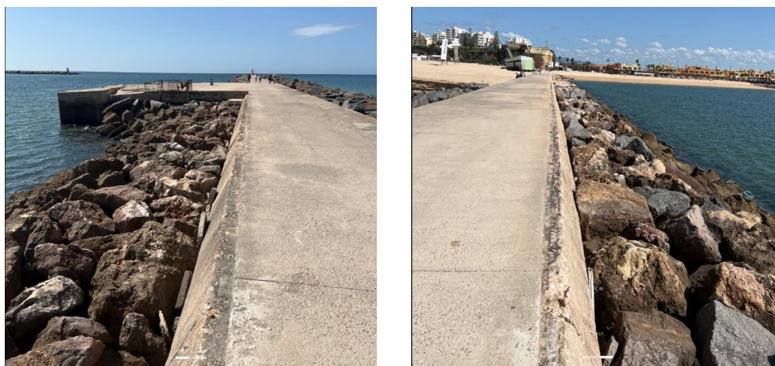
Figura 4.4 – Troço A (ponto 4, talude interior e coroamento). Esquerda) vista sentido da cabeça; Direita) vista sentido enraizamento
