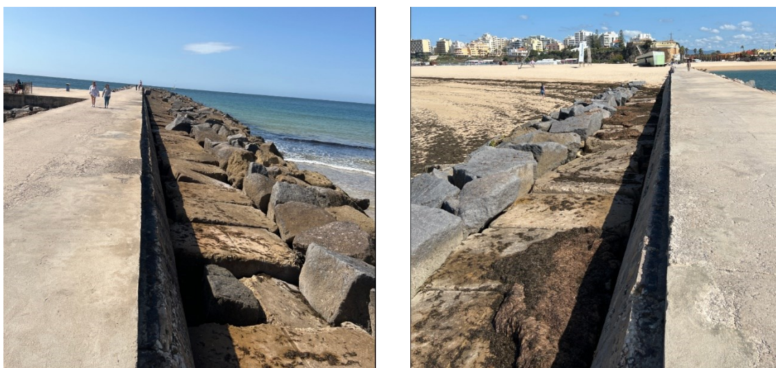
Figura 4.2 – Troço A (ponto 5, talude exterior e coroamento). Esquerda) vista sentido da cabeça; Direita) vista sentido do enraizamento
