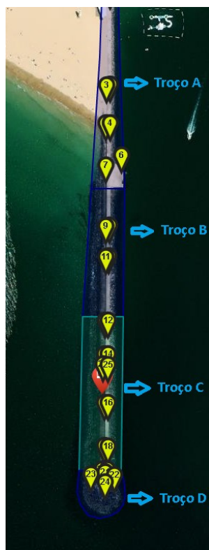
Figura 4.1 – Quebra-mar poente de Portimão (Divisão por troços) Adaptado de: osom.lnec.pt
