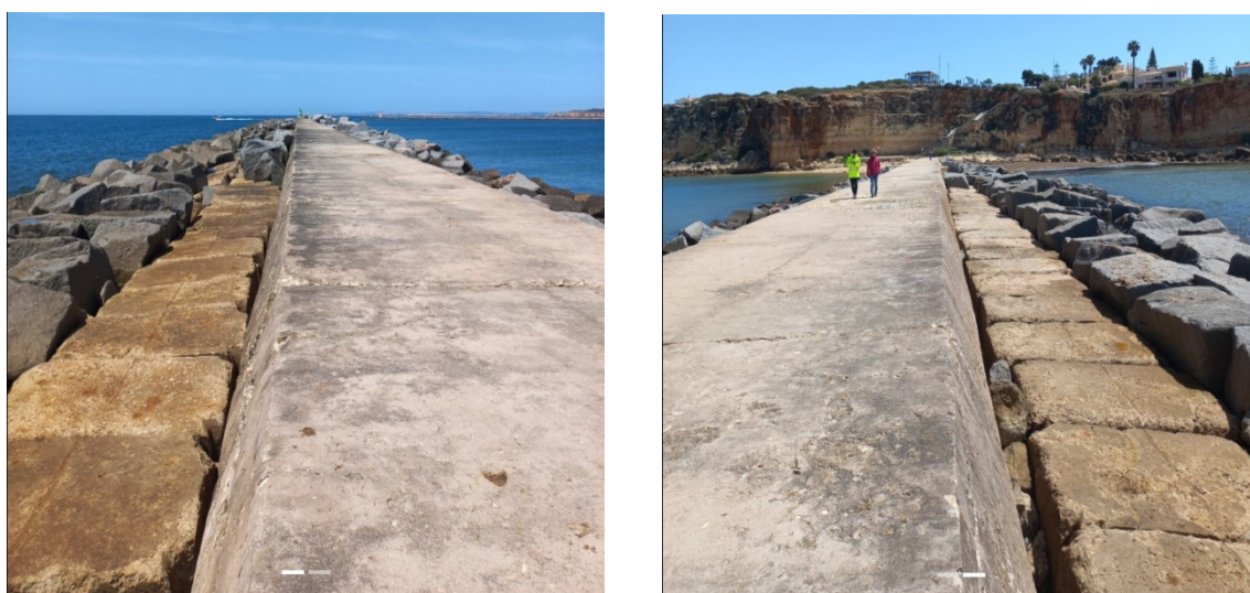
Figura 4.20 – Troço E (ponto 3, talude exterior e coroamento). Esquerda) vista sentido da cabeça; Direita) vista sentido do enraizamento
