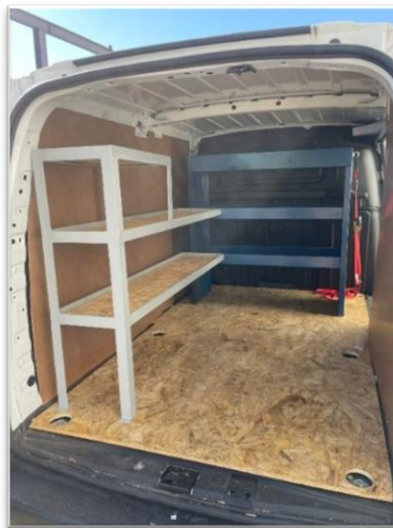
Figura 30 - Instalação de novas prateleiras na viatura (viatura de eletricitas)
