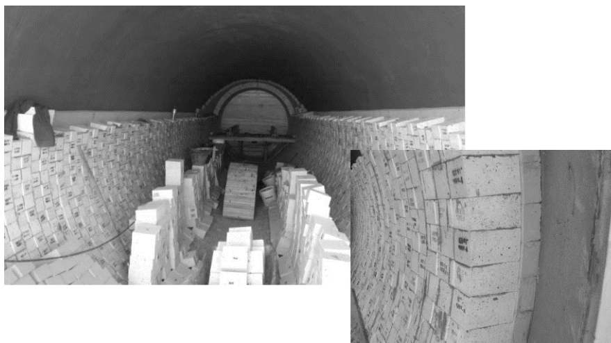
Figura 21 – Colocação do refratário no interior do FR [22]
