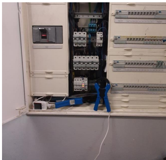
Figura 25 - Instalação de analisadores de rede
