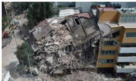
Figura 2.13 - Colapso parcial de estruturas, [adaptado de (Lima 2021)].
