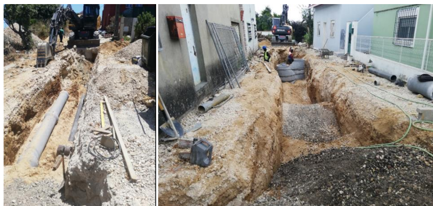
Figura 3.4 – Aberturas de valas para colocação de rede de drenagem.
