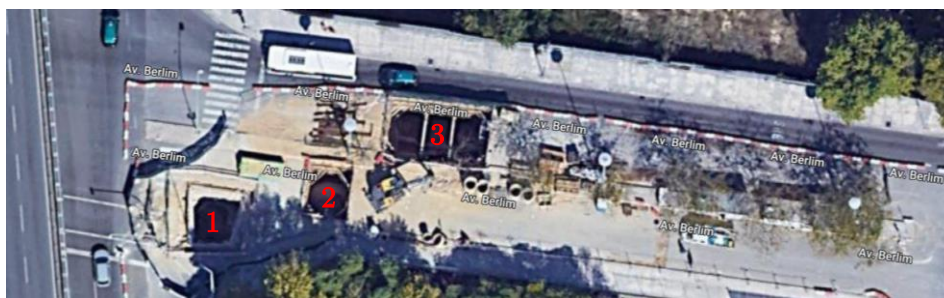
Figura 6.19 – Vista aérea do Google Earth , das caixas na Av. a de Berlim.
