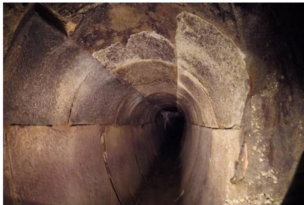
Figura 4.6 – Coletor oval em saimés - Rua das Portas de Santo Antão - Fotografia Nuno Alexandre; Arquivo Departamento de Saneamento; Câmara Municipal de Lisboa
