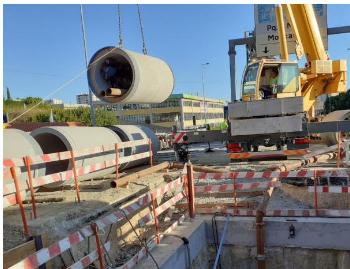
Figura 6.10 – Colocação do tubo.
