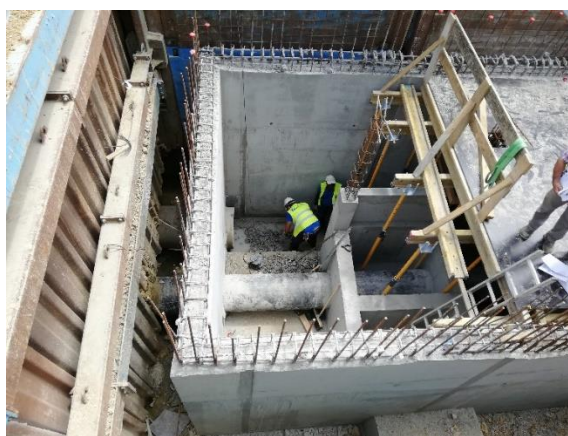
Figura 6.24 – Caixa do apeadeiro de Moscavide vista N/S.
