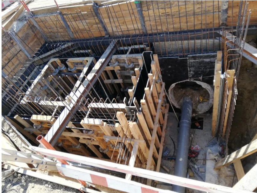
Figura 6.27 – Construção da nova caixa na rua dos Argonautas.
