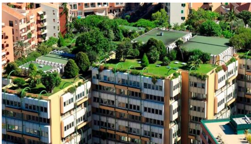
Figura 2.4 – Exemplo da implementação de um greenroof [45]
