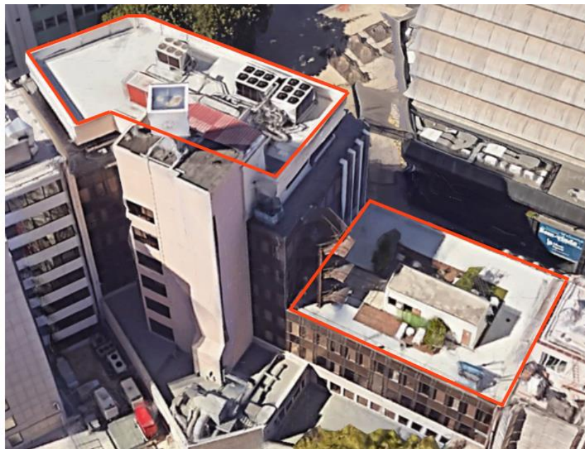
Figura 3.11 - Coberturas do edifício (adaptado de [68])
