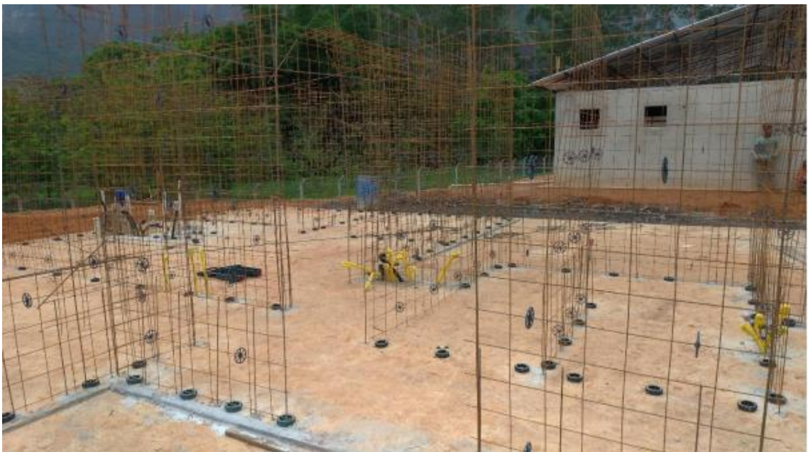
Figura 5.64 – Serviço de montagem das armaduras
