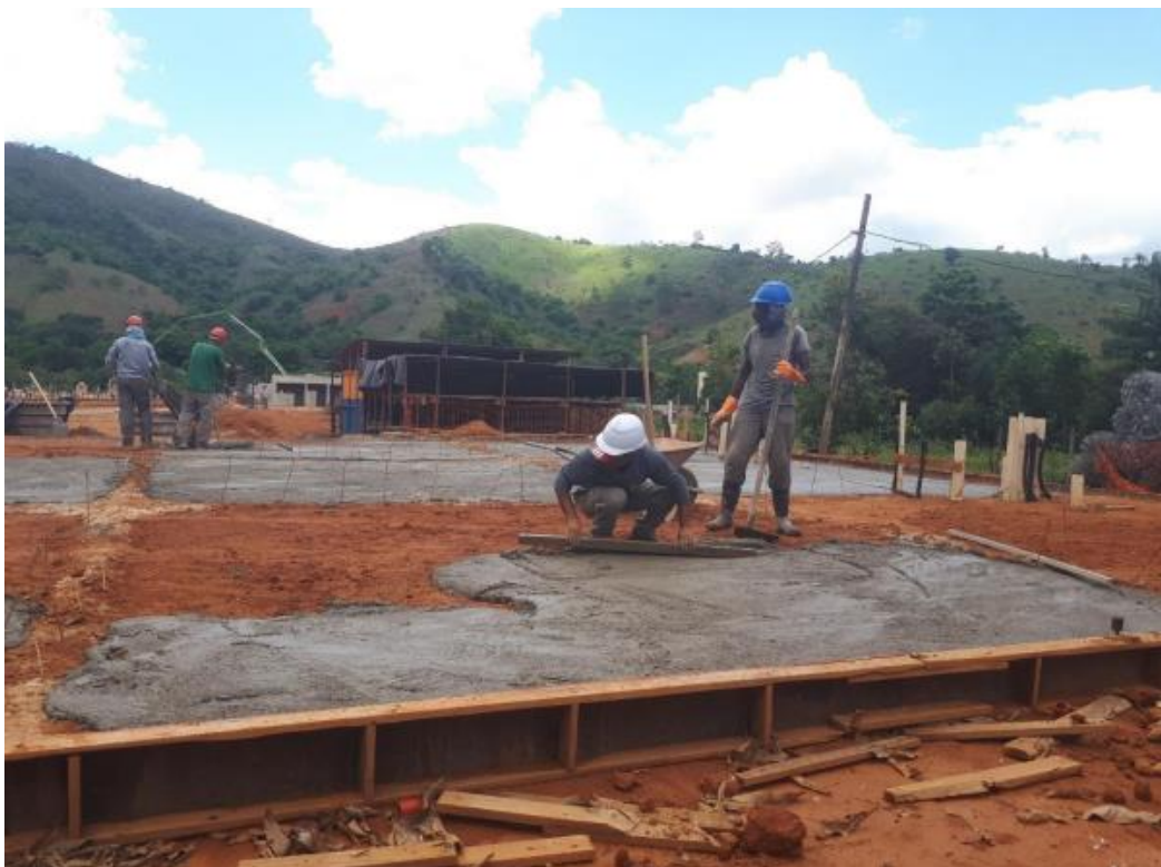
Figura 5.53 – Aplicação de camada de argamassa de regularização do aterro
