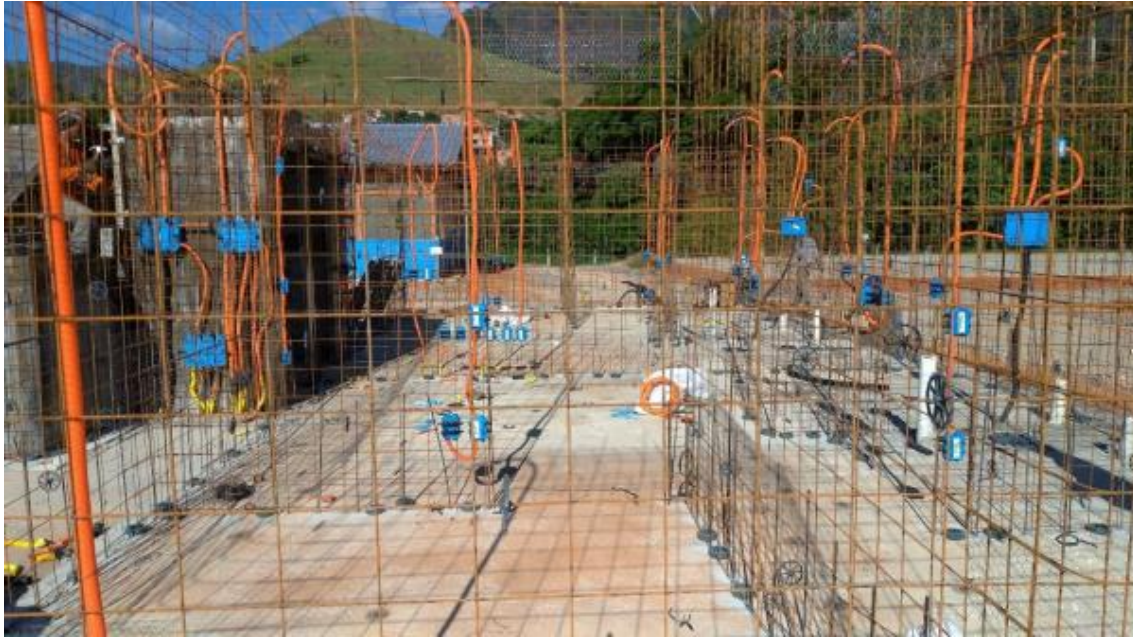
Figura 5.65 – Instalação dos kits elétricos das paredes
