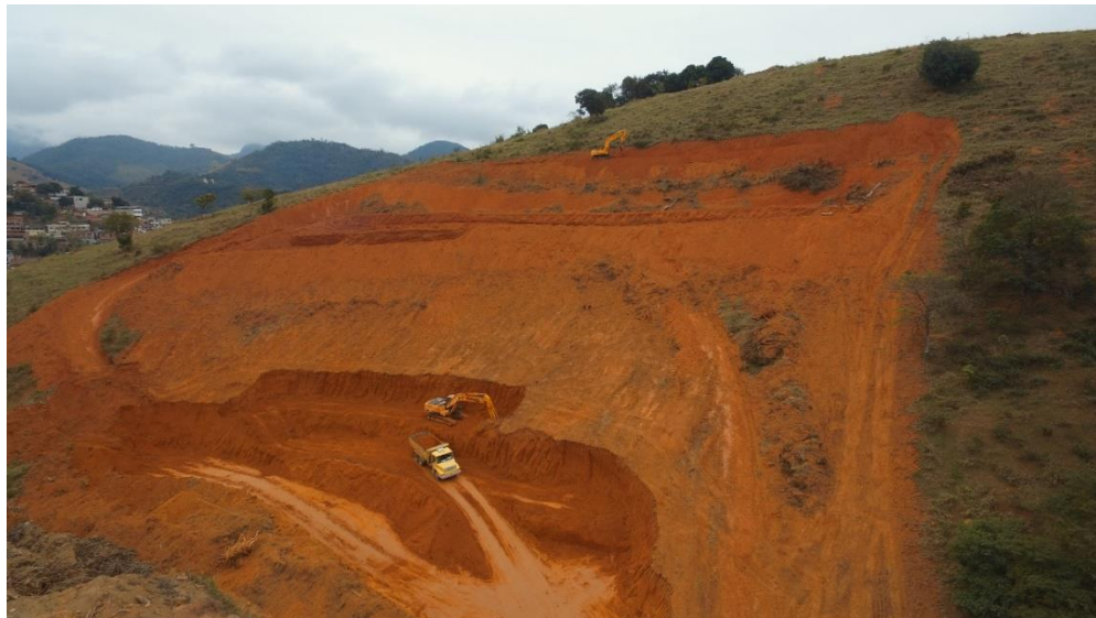
Figura 5.14 – Remoção do solo da mancha de empréstimo
