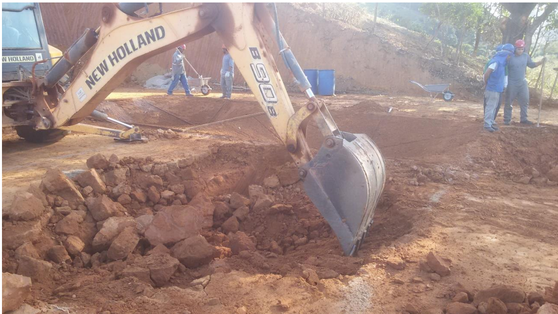
Figura 5.35 – Escavação dos módulos com retroescavadora
