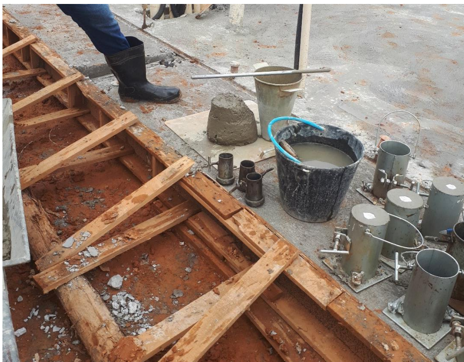
Figura 5.77 – Realização do ensaio slump
