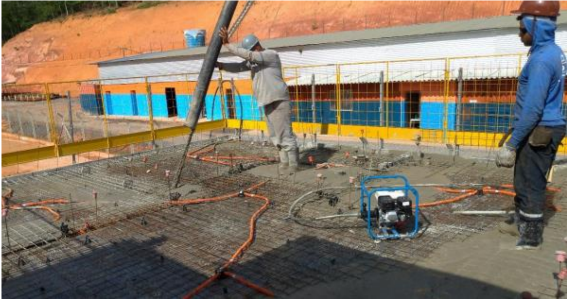
Figura 5.71 – Execução da betonagem
