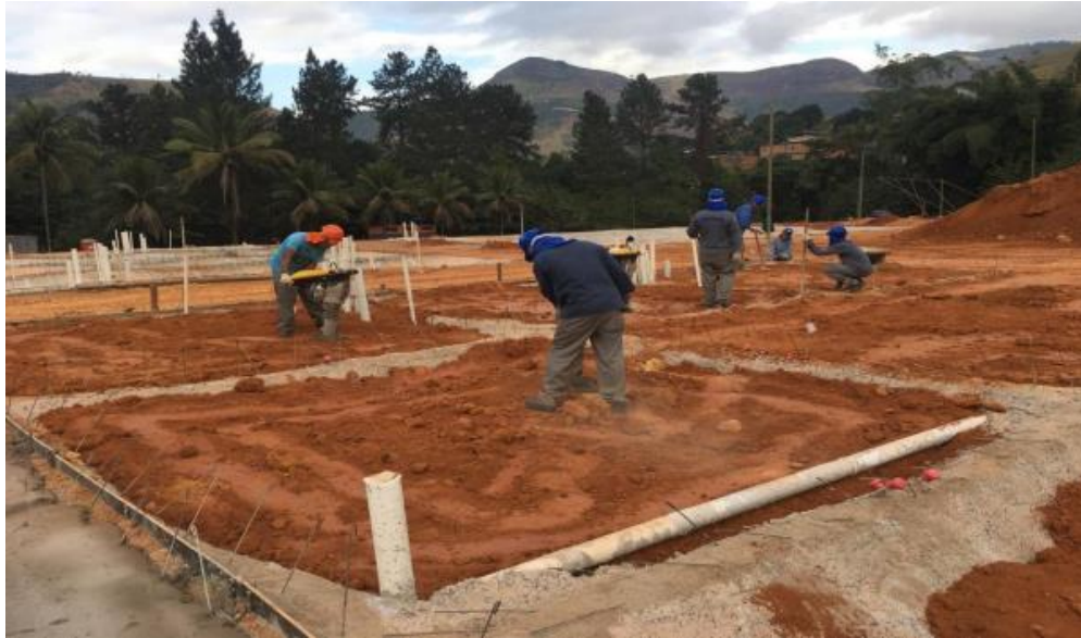
Figura 5.52 – Processo de aterro dos módulos
