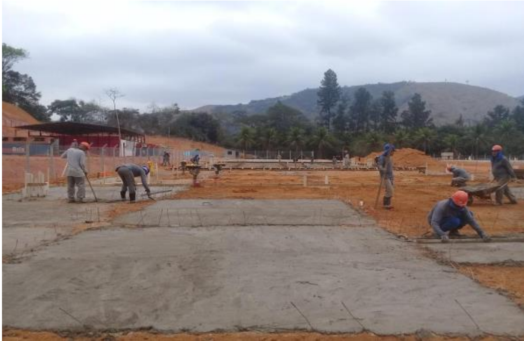
Figura 5.54 – Execução da camada de argamassa de regularização sobre o aterro
