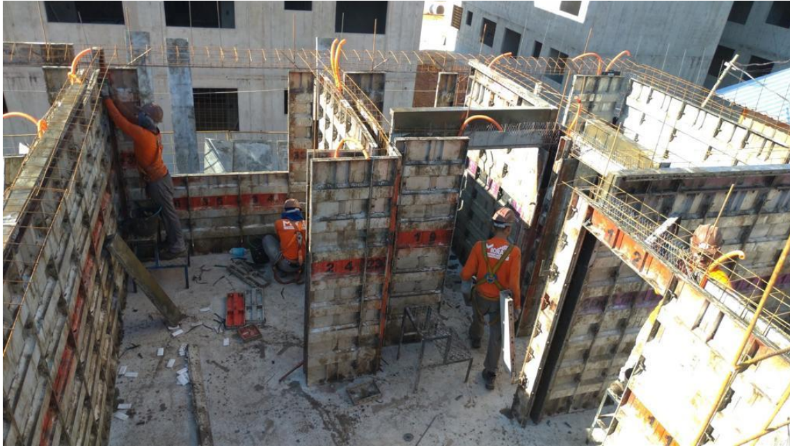
Figura 5.69 – Montagens das cofragens
