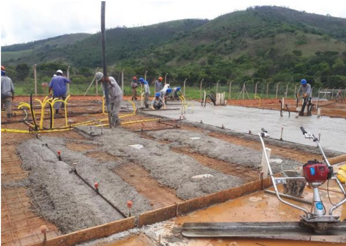
Figura 5.60 – Betonagem da laje em radier
