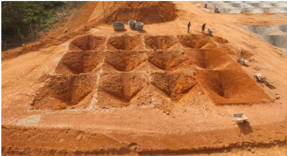
Figura 5.37 – Escavação dos módulos
