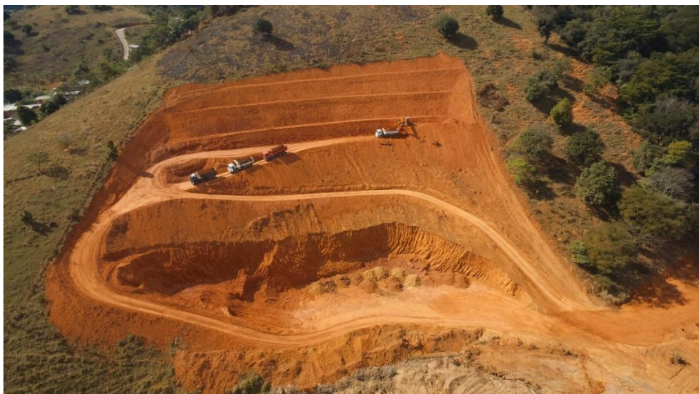
Figura 5.15 – Remoção do solo da mancha de empréstimo
