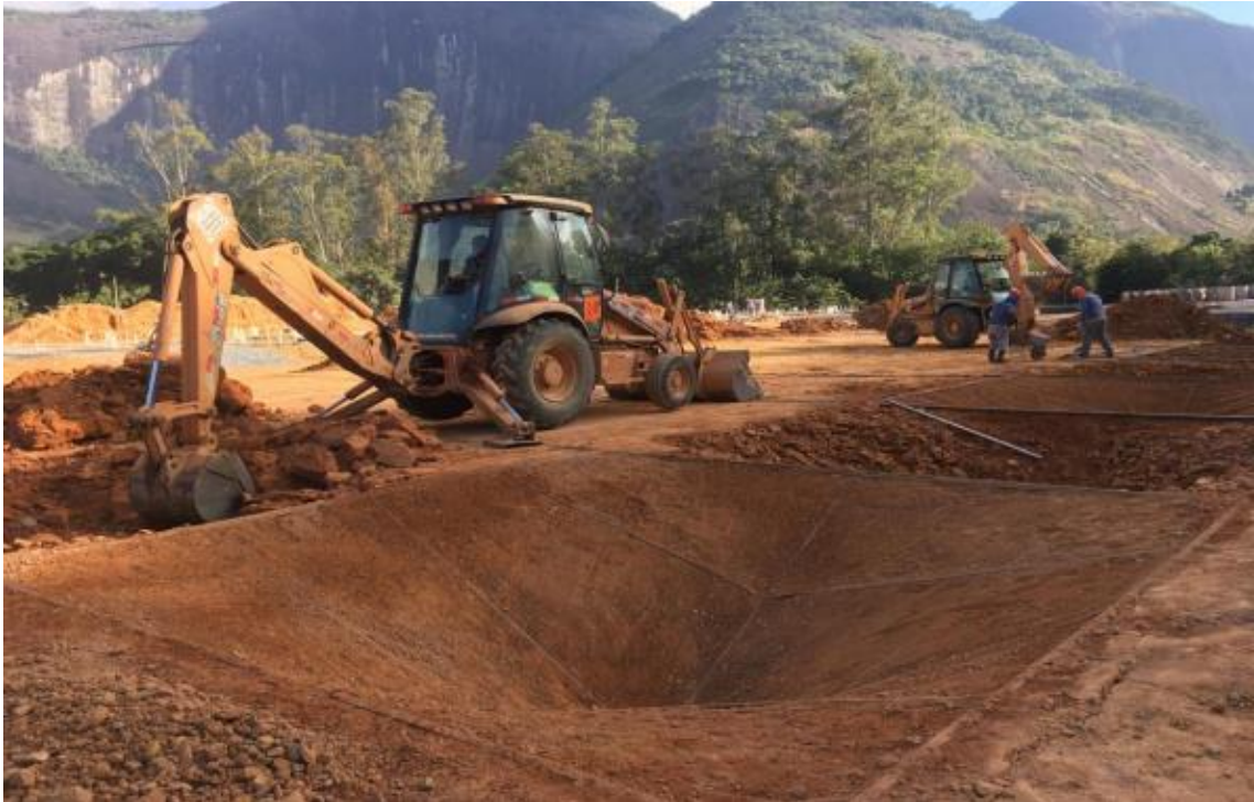
Figura 5.36 – Escavação dos módulos
