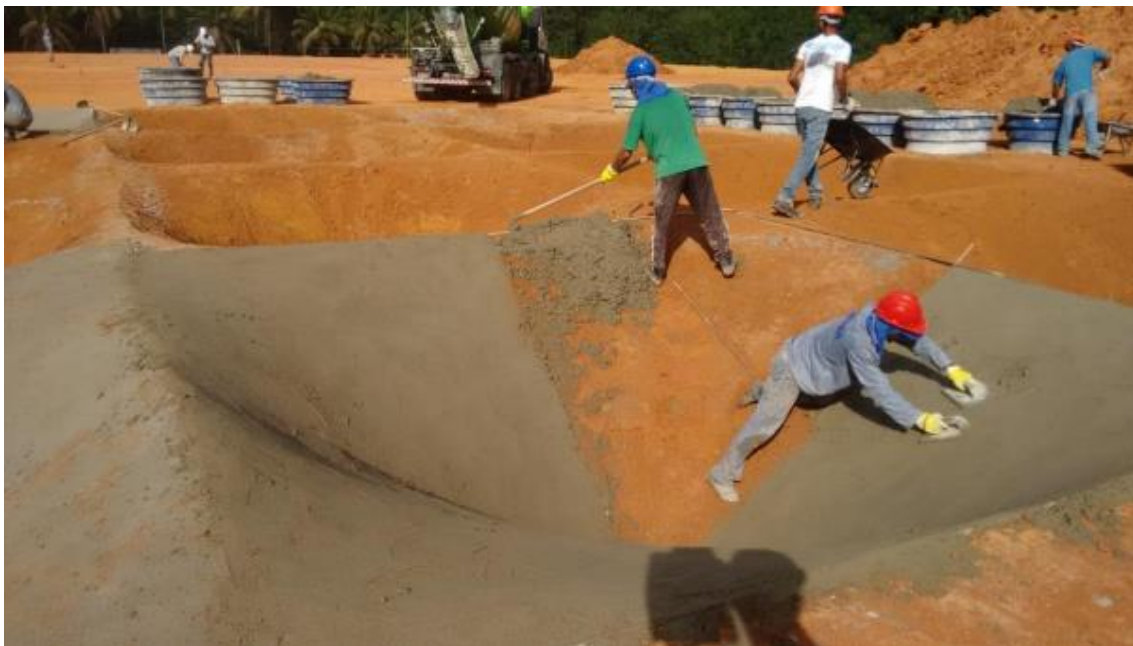
Figura 5.39 – Aplicação da camada de argamassa para regularização
