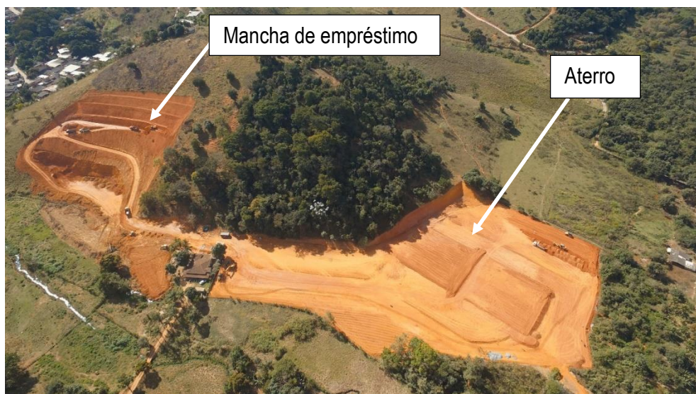
Figura 5.16 – Vista geral da mancha de empréstimo e do local de construção do aterro
