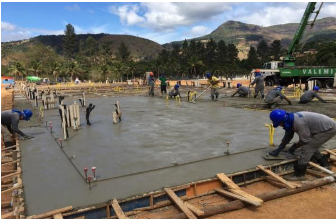
Figura 5.61 – Execução da betonagem da laje em radier
