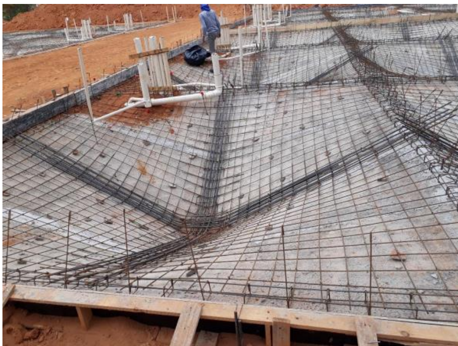
Figura 5.48 – Montagem das armações nos módulos
