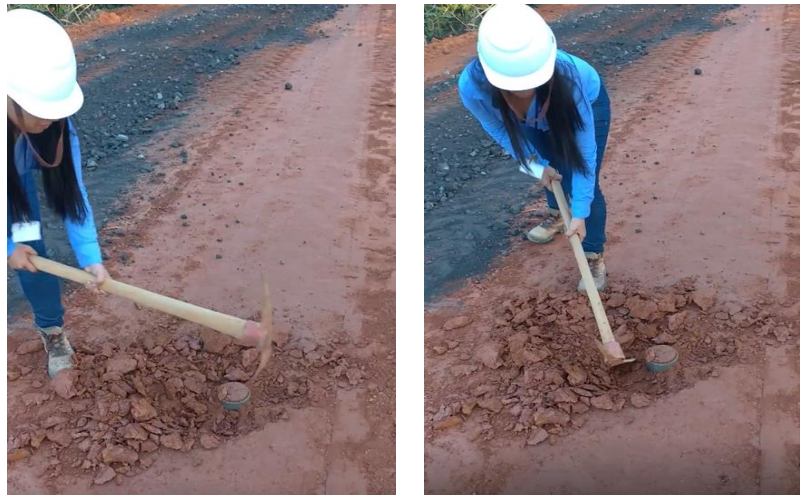
Figura 5.23 – Remoção do extractor
