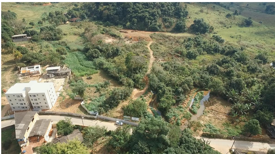
Figura 5.6 – Terreno onde foi construído o condomínio Buritis
