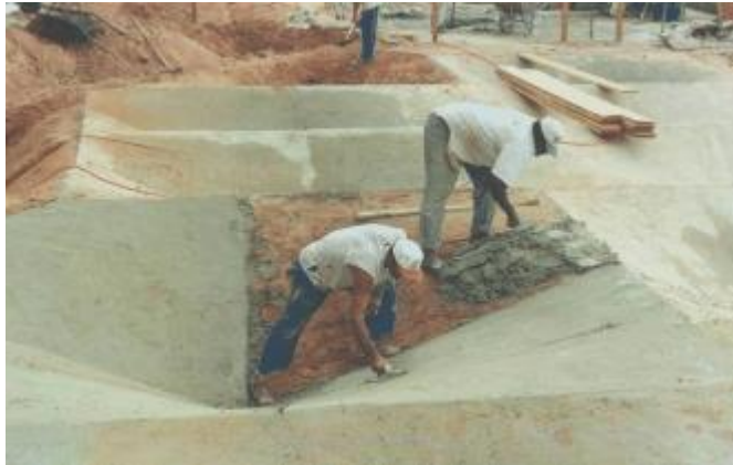
Figura 4.35 – Execução da camada de regularização (Filgueiras et al., 2012)
