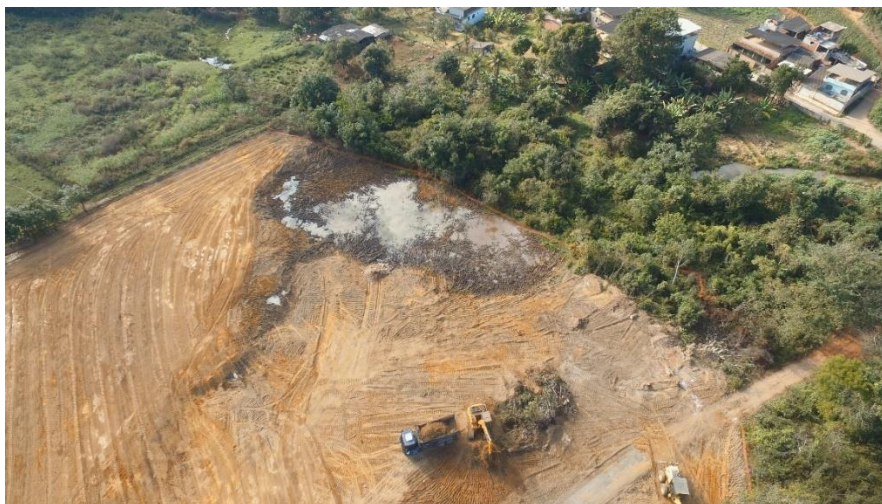
Figura 5.7 – Limpeza do terreno com remoção da camada vegetal
