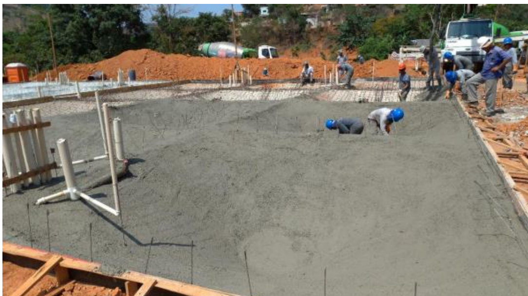
Figura 5.49 – Betonagem dos módulos
