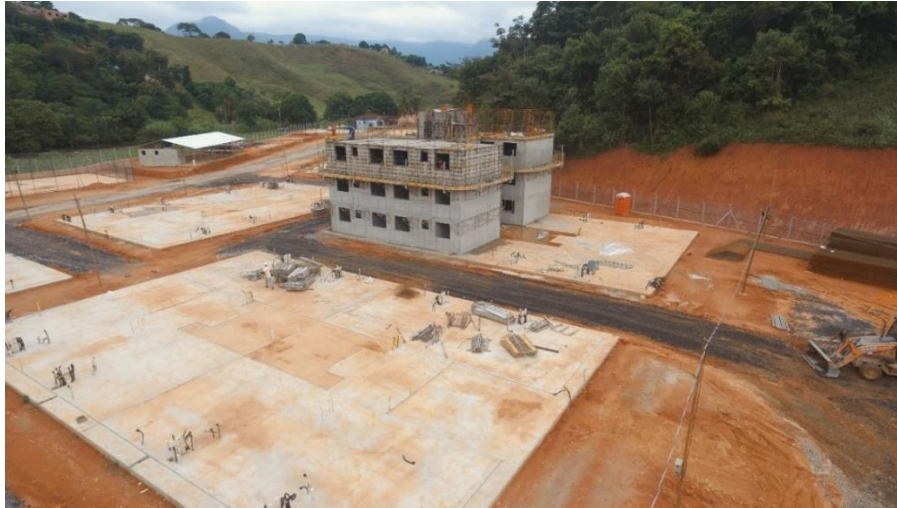
Figura 5.5 – Execução da estrutura em betão armado utilizando cofragens metálicas
