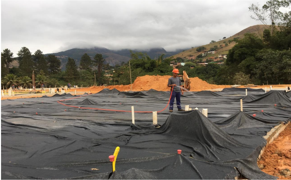
Figura 5.62 – Execução da cura do betão através de manta húmida
