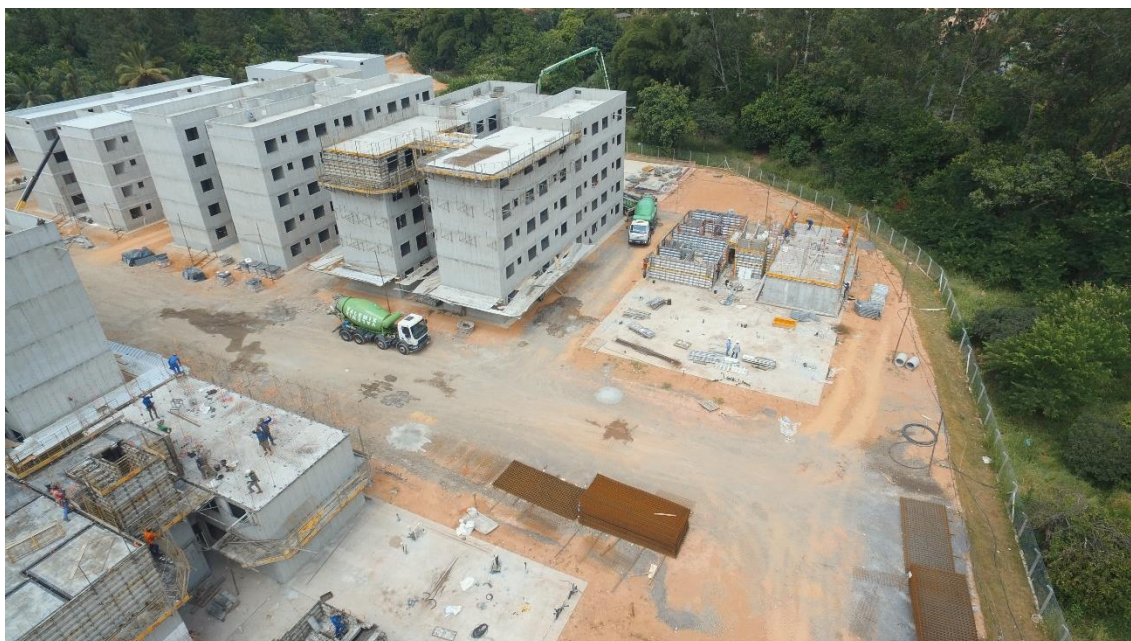
Figura 5.75 – Execução da betonagem dos edifícios
