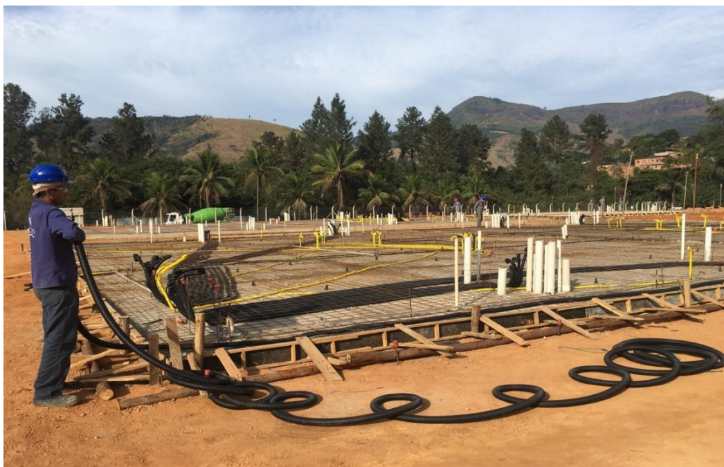
Figura 5.58 – Execução das instalações elétricas e de telecomunicações
