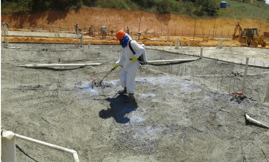
Figura 5.50 – Cura química dos módulos após a betonagem
