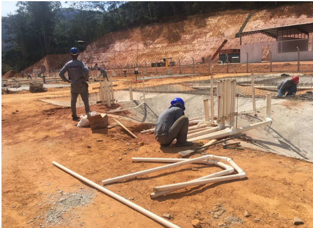
Figura 5.41 – Instalação das tubagens hidrossanitárias
