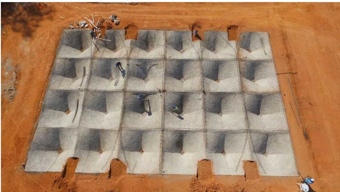
Figura 4.39 – Execução da fundação radier em parabolóide hiperbólico, condomínio Contente I.
