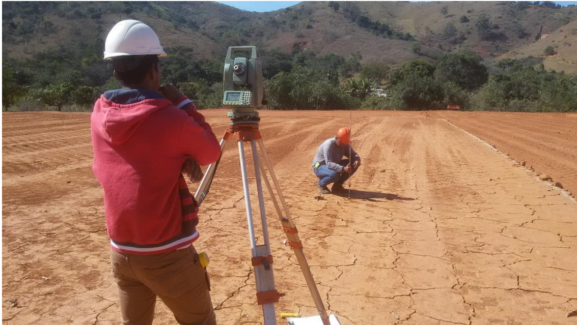
Figura 5.34 – Localização dos módulos com o auxílio da topografia.
