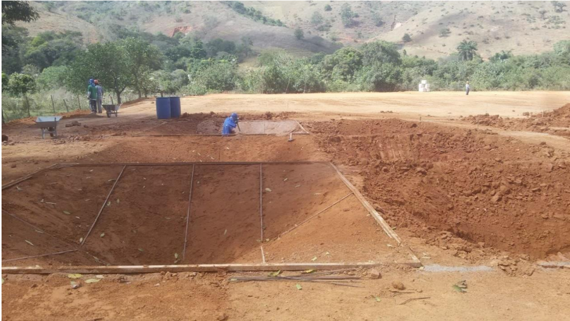
Figura 5.38 – Utilização de gabarit para regularização dos módulos
