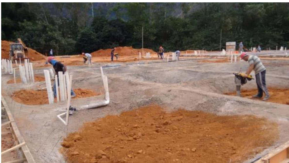
Figura 5.51 – Aterro dos módulos
