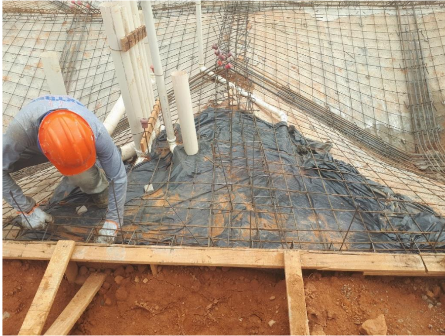
Figura 5.42 – Colocação de lona plástica com o intuito de proteger as armaduras do contato com o solo.
