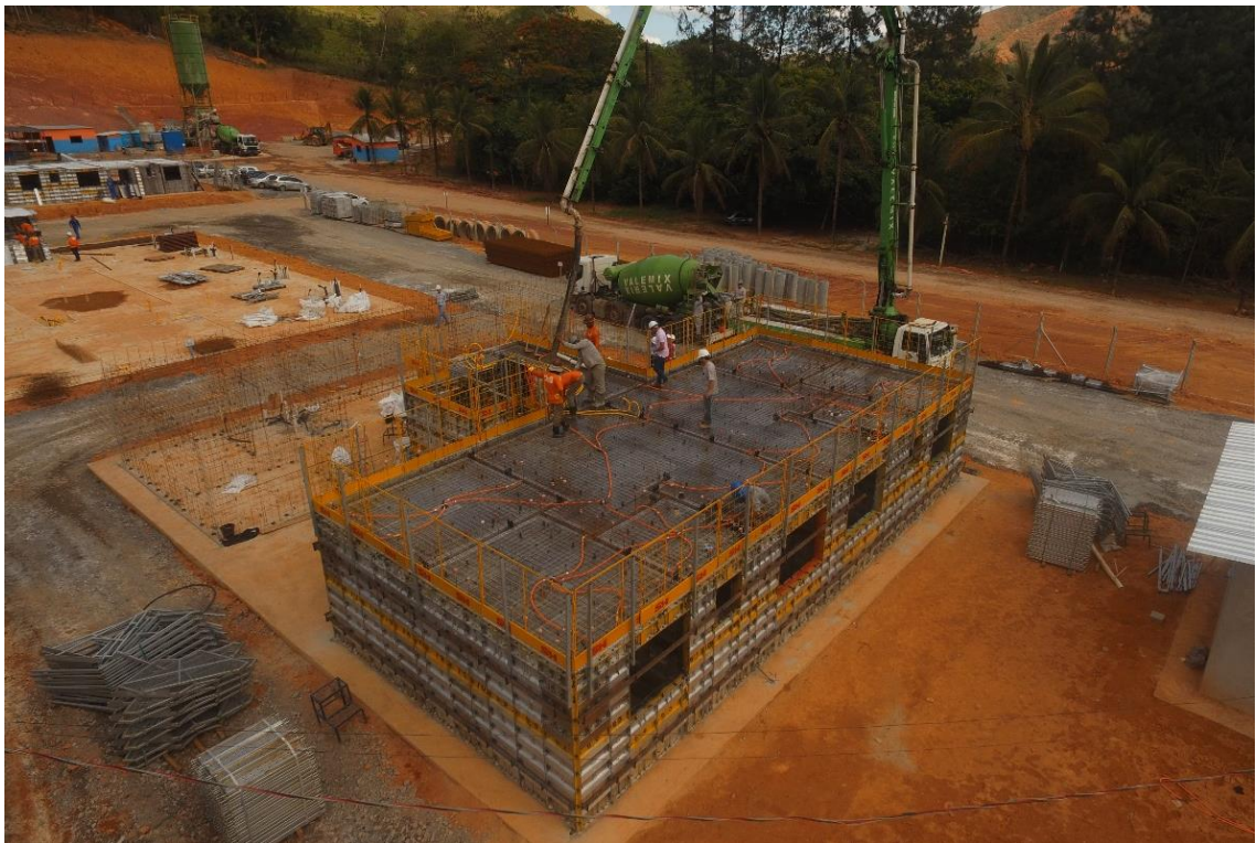
Figura 5.72 – Execução da betonagem
