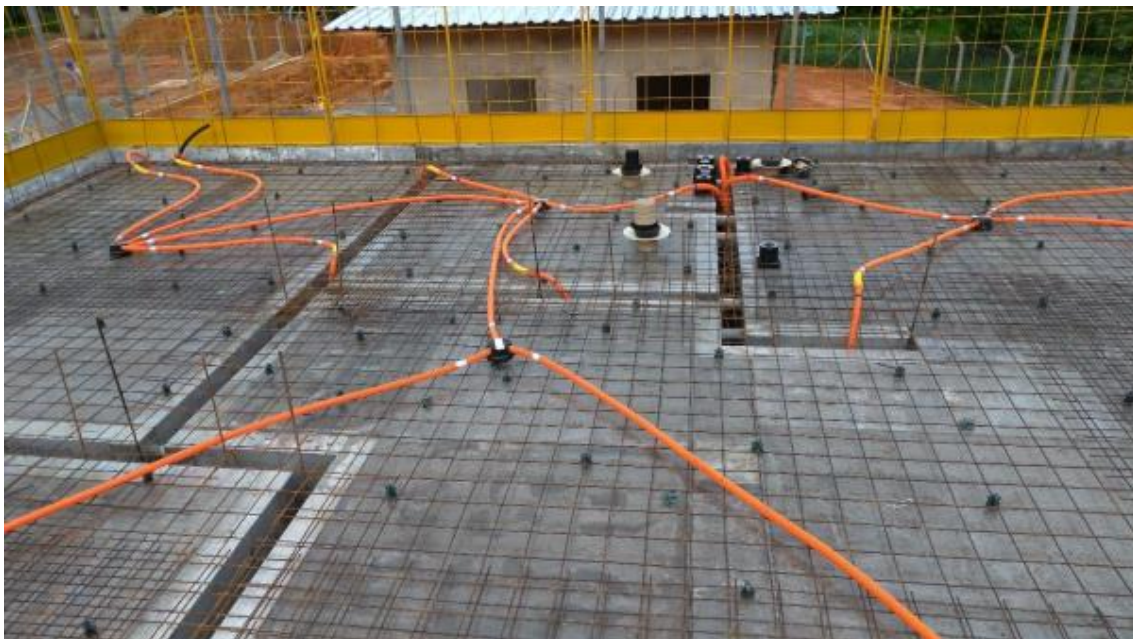
Figura 5.66 – Instalação dos kits elétricos da laje do piso elevado
