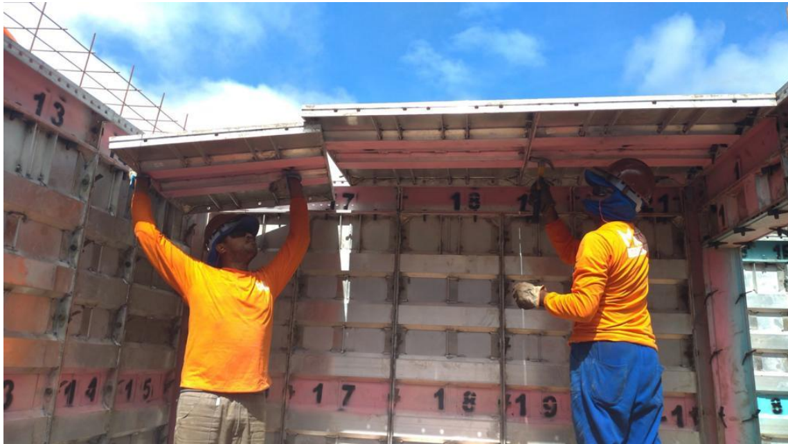
Figura 5.68 – Montagem das cofragens internas
