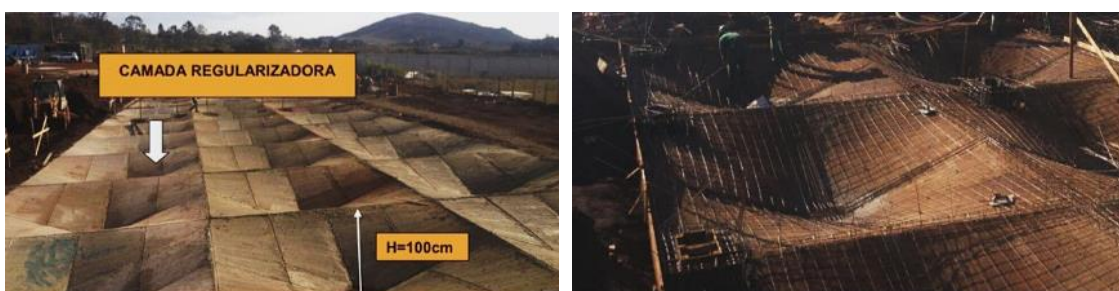
Figura 4.37 – Pavilhão industrial em Nova Lima, Minas Gerais (Benkendorf, 2015)
