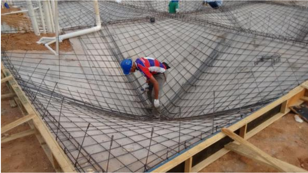
Figura 5.46 – Execução da montagem das armaduras em cada módulo
