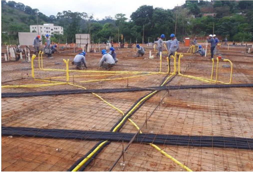
Figura 5.57 – Armaduras do radier
