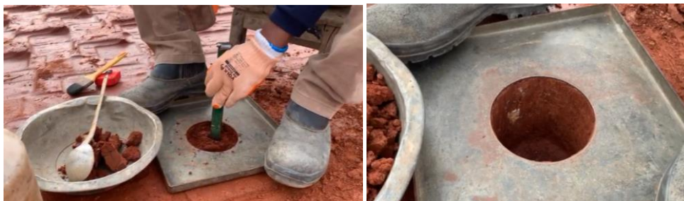
Figura 5.19 – Realização da cavidade no solo compactado (Cangussu, 2022)
