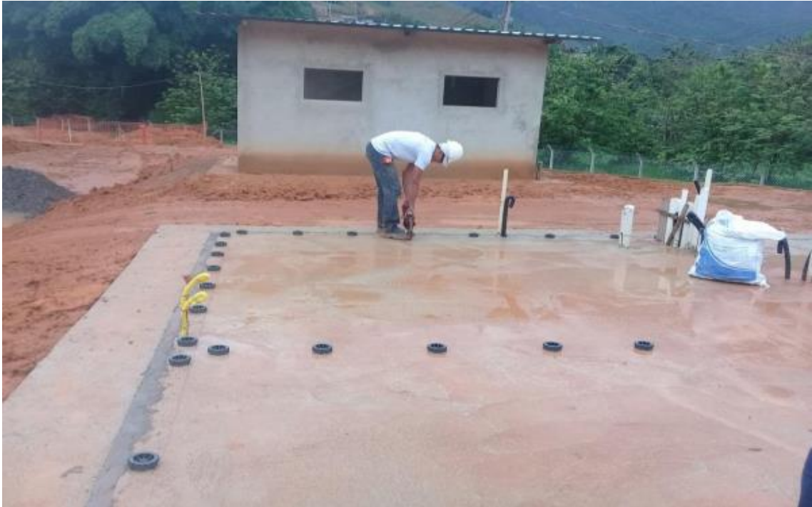
Figura 5.63 – Execução das marcações e fixação dos espaçadores das paredes
