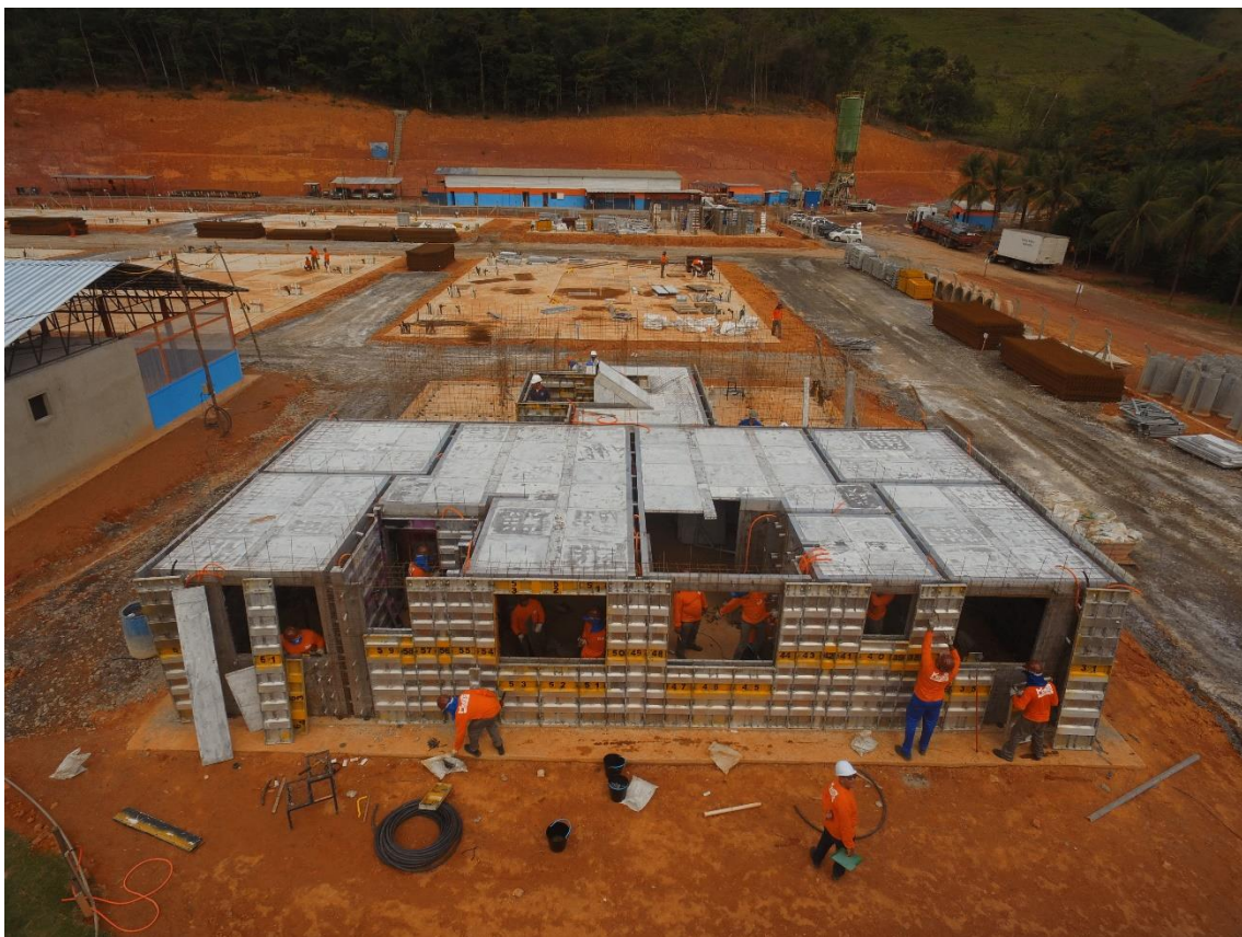
Figura 5.70 – Montagem das cofragens
