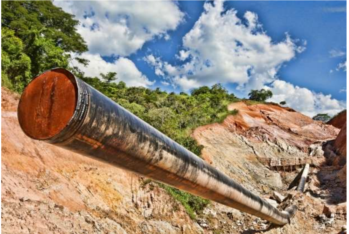
Figura 7 - Construção do Mineroduto. (Anglo American Brasil, 2021)
