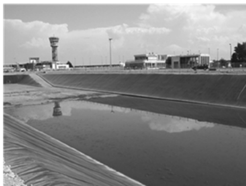
Figura 8.17 Rampa de acesso à lagoa para remoção de lamas
