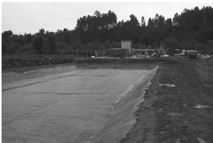
Figura 7.15 Construção de um leito de macrófitas
