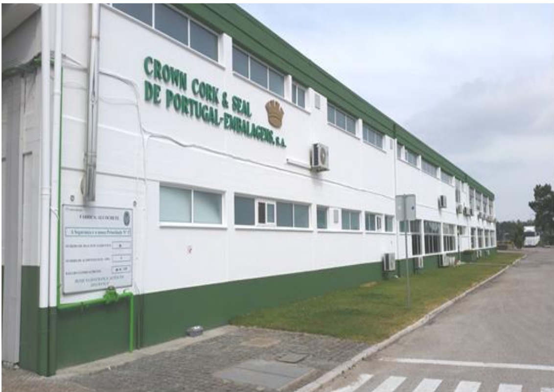
Figura 10: Instalações de Alcochete (entrada principal)
