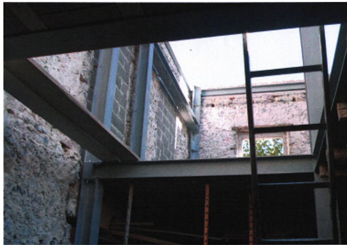
Figura 31 - Execução da nova estrutura com perfis metálicos “ligados” á face interior das paredes de alvenaria de pedra
