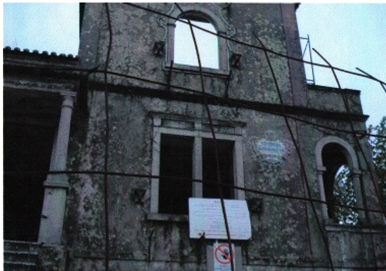
Figura 29 – Alçado Principal: Fase de demolição interior
