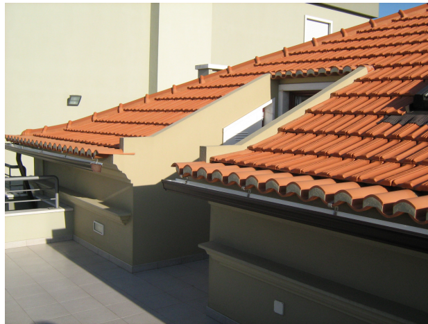
Figura 50 – Cobertura inclinada e terraço
