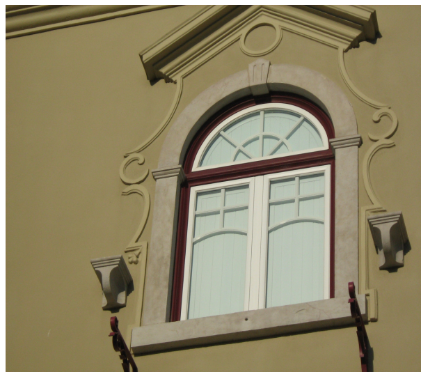
Figura 48 – Vão de janela na fachada principal
