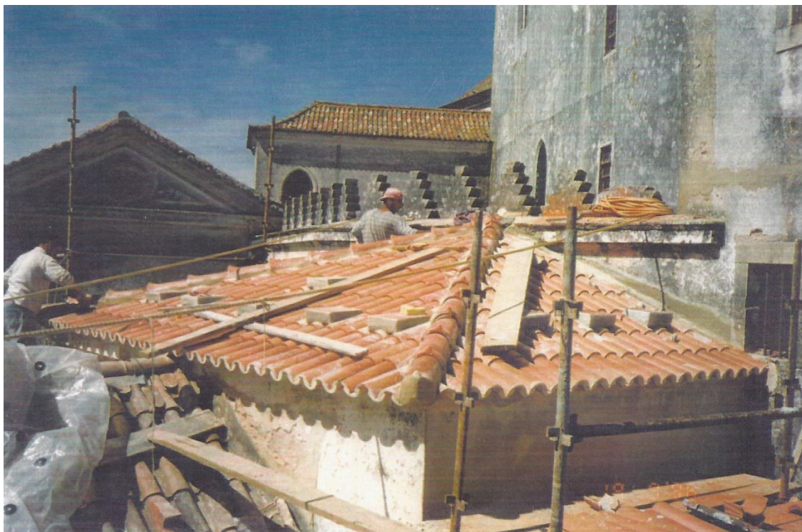
Fig. 5.18. – Reconstituição Total de Coberturas – Arrecadações (1996)
