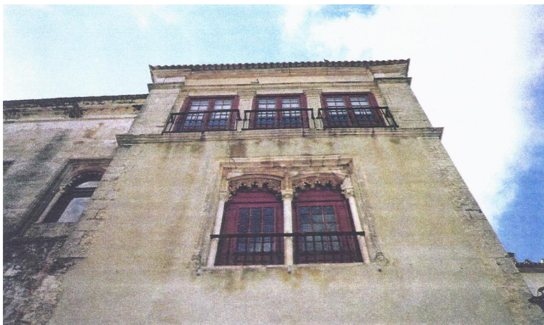
Fig. 3.19. – Guardas Metálicas – Fachada Principal (1994)
