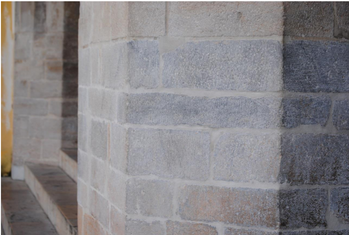
Fig. 6.11. – Juntas – Fachada Principal (2013)
