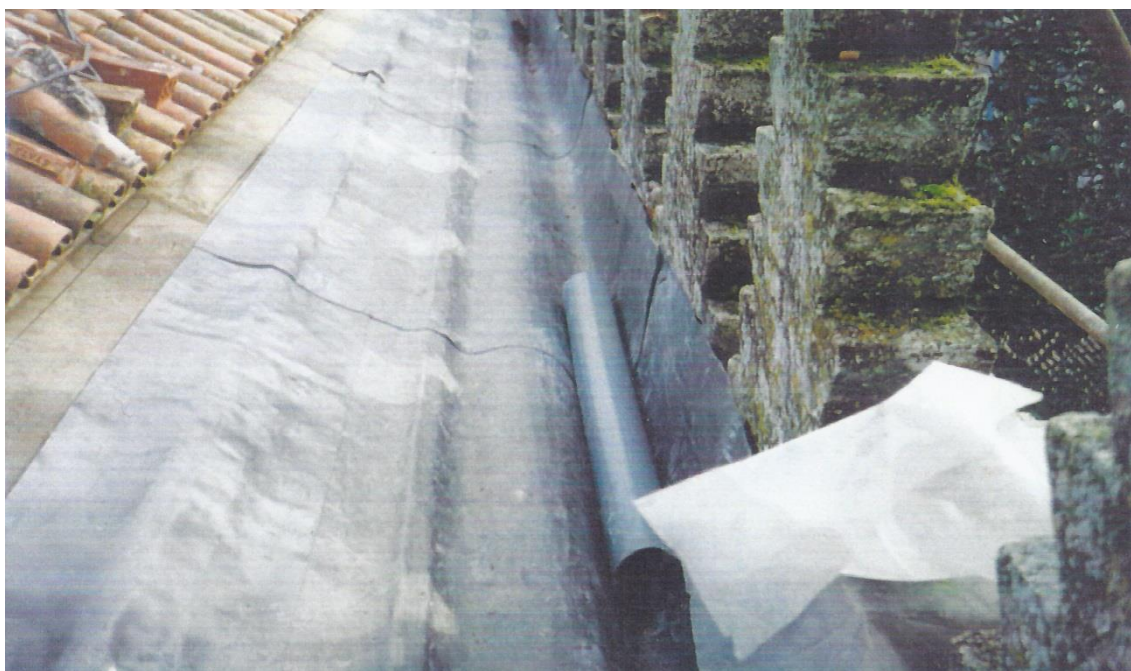
Fig. 5.16. – Algerozes em Chumbo (1996)
