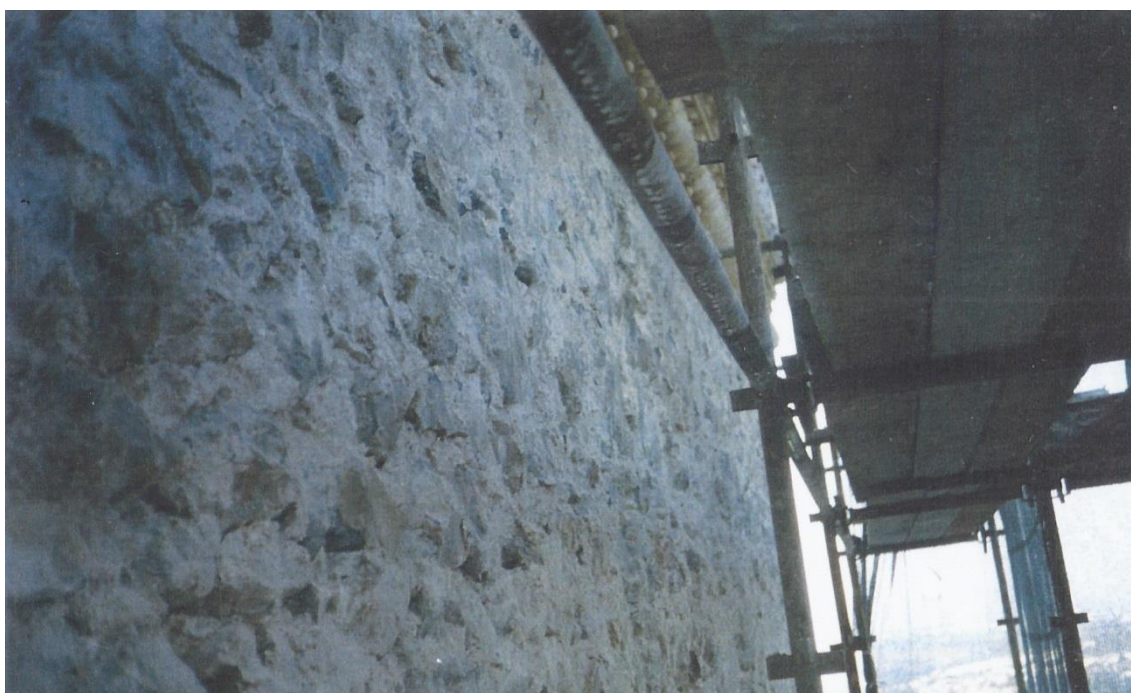
Fig. 5.1. – Remoção Total de Reboco – Torre dos Brasões (1996)
