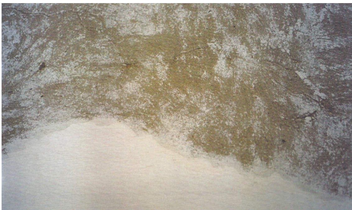
Fig. 5.2. – Remoção de Barramento/Pintura - Alçado Principal (1996)
