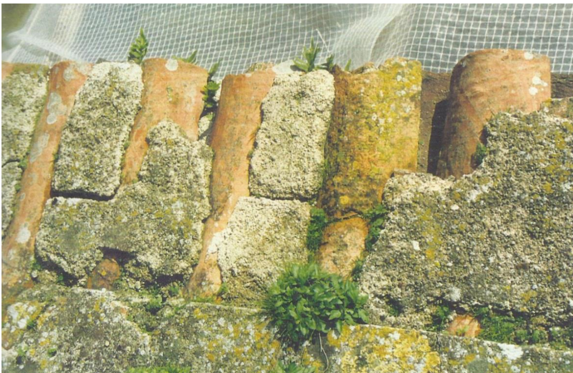
Fig. 4.18. – Beirado de Cobertura (1996)
