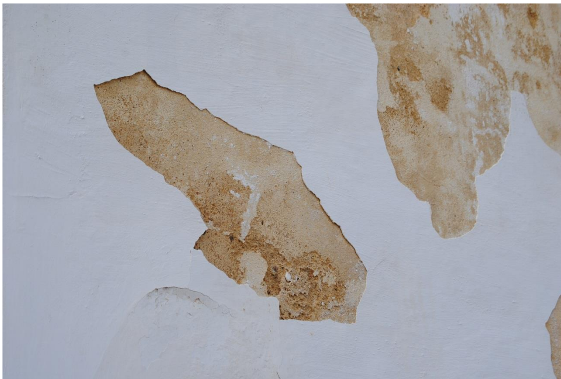
Fig. 6.8. – Destacamento da Caição - Fachada Principal (2013)
