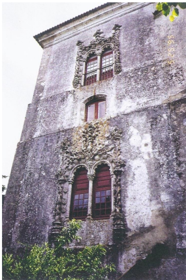
Fig. 3.7. – Fachada Norte – Parcial (1995)
