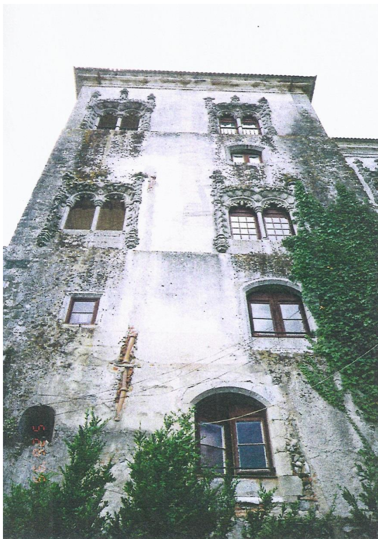
Fig. 3.2. – Fachada Norte - Parcial (1995)
