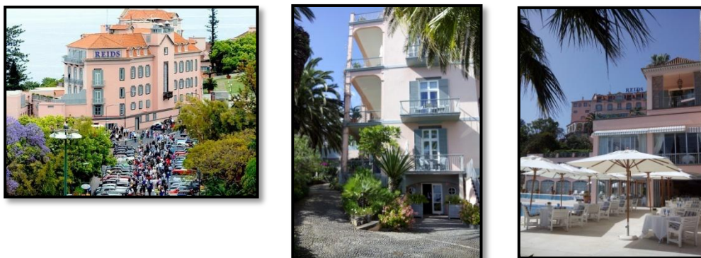
Fig. 11 – Fachada lateral do hotel – vista da Estrada Monumental; Antiga entrada do hotel; Fachada traseira do hotel – vista do Restaurante Jardim (da esq. para a dta.)
