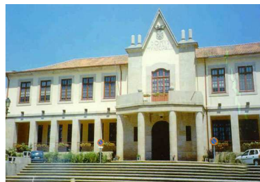
Vila Flor (Mirandela / Porto) Edifício adaptado
