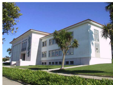
Santiago do Cacém (Santiago do Cacém / Évora) Arq. Raul Rodrigues Lima Inaugurado em 28/07/1968 Cobertura inclinada
