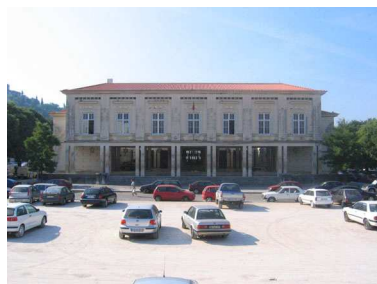
Tomar (Tomar / Coimbra) Arq. Januário Godinho de Almeida Inaugurado em 01/03/1959 Cobertura inclinada
