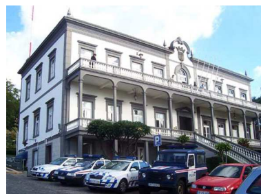
Santa Cruz (Funchal / Lisboa) Edifício adaptado
