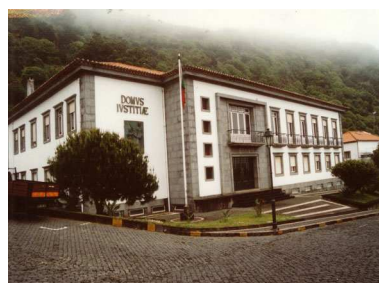
Velas (Angra do Heroísmo / Lisboa) Arq. Francisco Augusto Baptista Concluído em 1973 Cobertura inclinada
