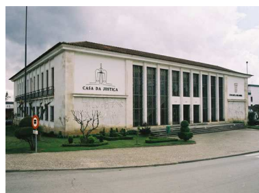
Soure (Pombal / Coimbra) Arq. Luís Amoroso Lopes Inaugurado em 26/11/1972 Cobertura inclinada
