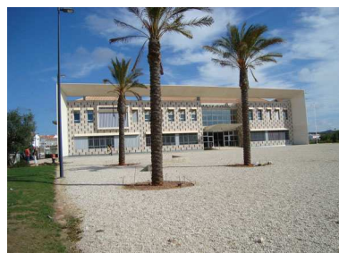
Silves (Portimão / Évora) Arq. Amílcar Pires Inaugurado em 09/05/2006 Cobertura plana
