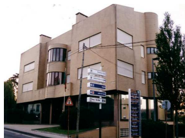
Valongo (Gondomar / Porto) Edifício adaptado
