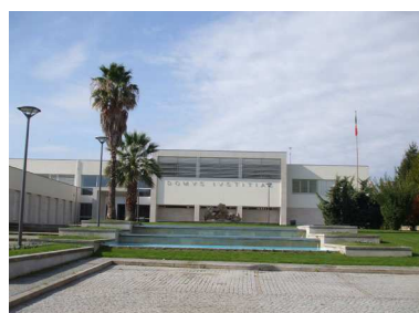
Valpaços (Chaves / Porto) Arq. Luís Oliveira Martins Concluído em 1986 Cobertura inclinada
