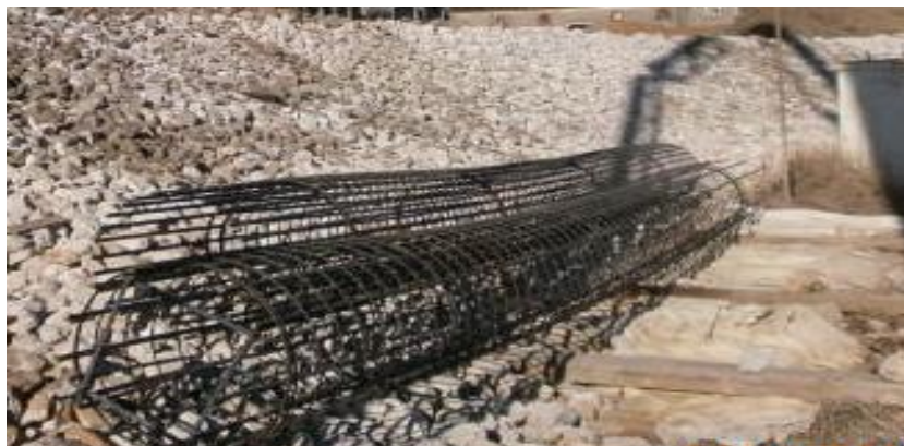
Imagem 13 - Armadura de estacas com tubos para ensaio Cross-Hole
