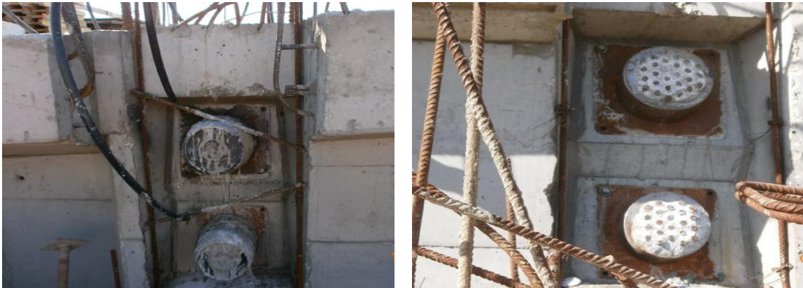
Imagem 10 - Selagem dos cabos de pré-esforço num topo do tabuleiro
