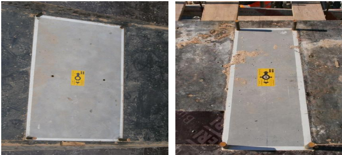
Imagem 9 – Aparelhos de apoio do alinhamento de pilares P9 (à esquerda) e carlinga do encontro (à direita)
