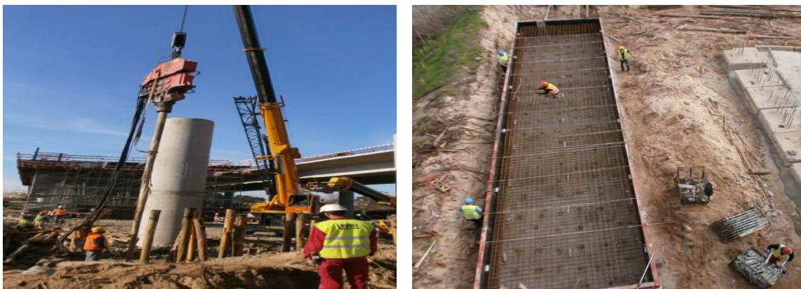
Imagem 6 - Cravação de estacas de madeira (à esquerda), cofragem e colocação do aço passivo no maciço de encabeçamento (à direita)
