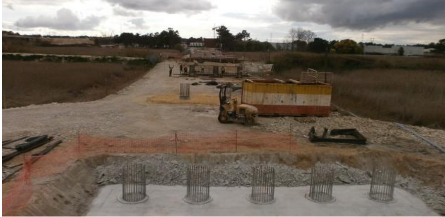
Imagem 16 - Estacas concluídas do alinhamento P8 ao E2
