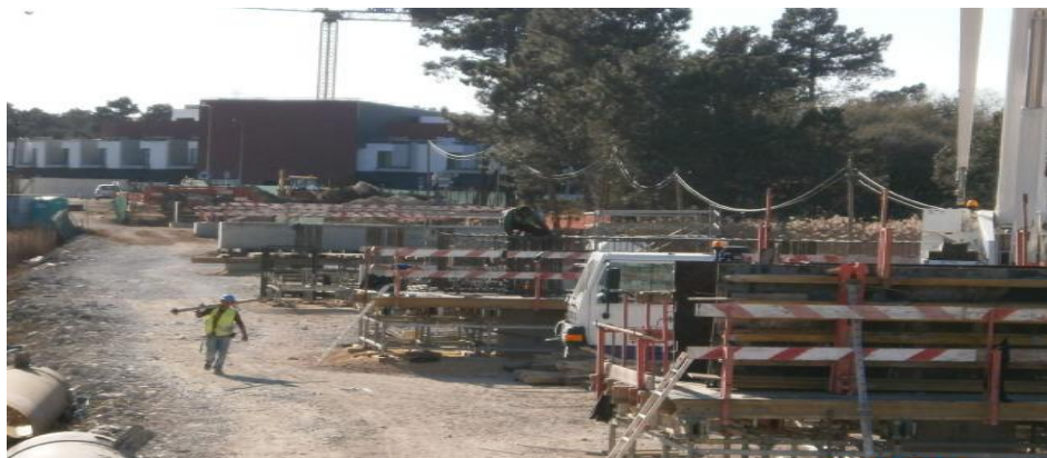
Imagem 15 - Vigas travessa (alinhamento P1 ao P5)
