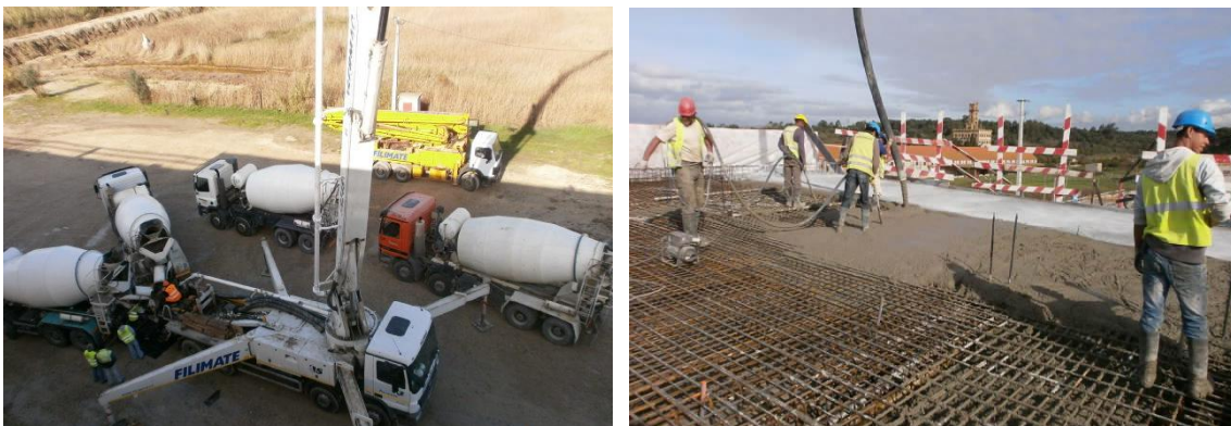
Imagem 20 - Betonagem do tabuleiro sobre o Rio de Coina
