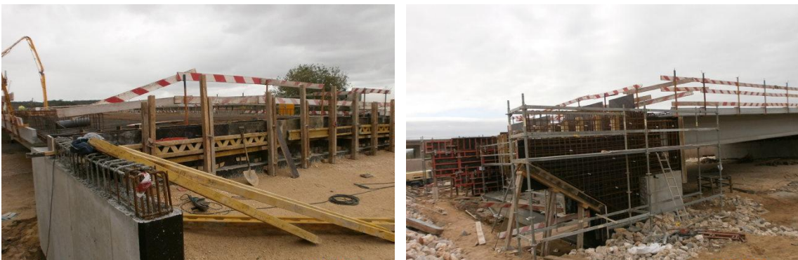
Imagem 19 - Cofragem do muro de testa e cachorro (à esquerda) e muros de ala (à direita)
