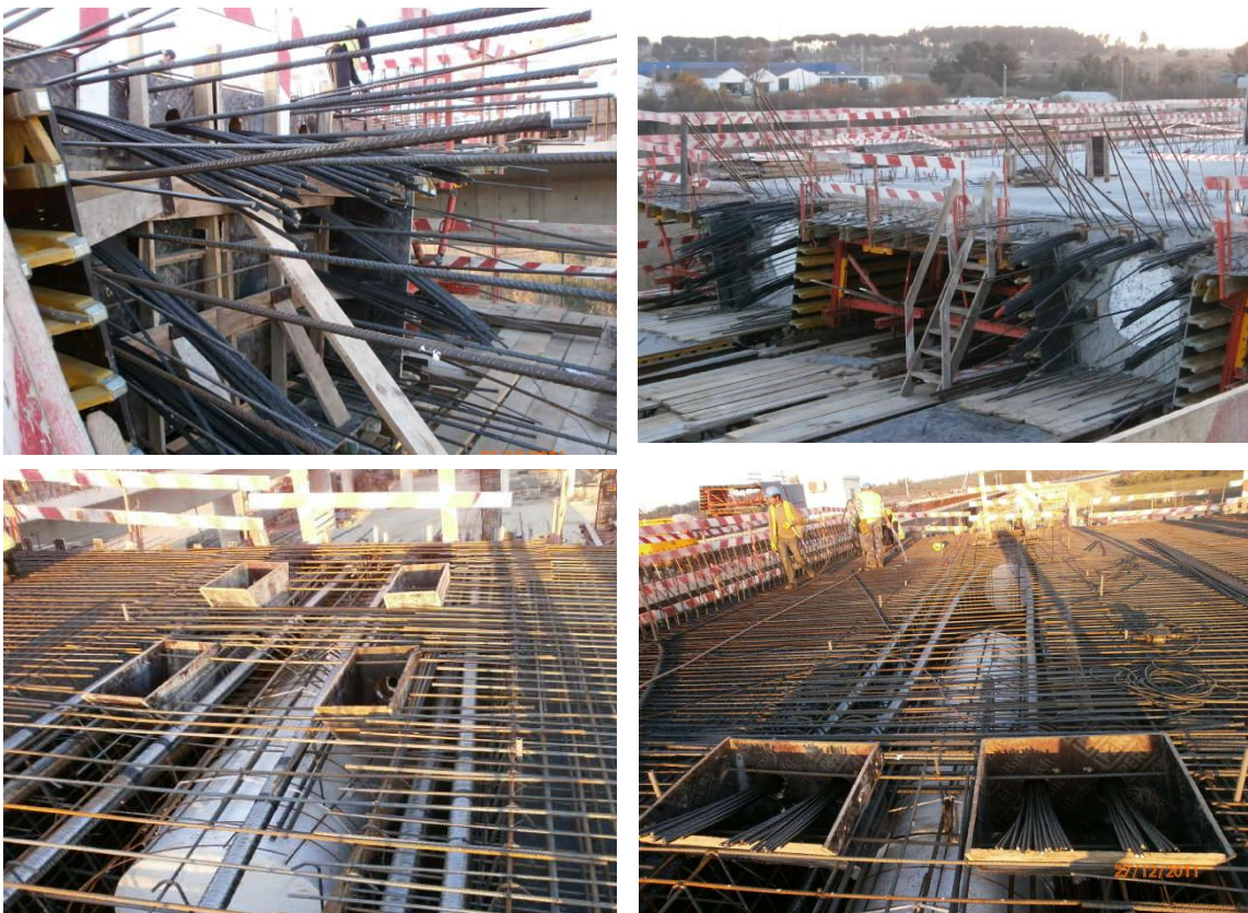
Imagem 7 - Reforço de pré-esforço no vão sobre o Rio de Coina. Imagens superiores, junta de betonagem 7 (com 8 cabos, ainda sem os cabos de reforço a começar na junta, enfiados na fase seguinte) e na imagem inferior esquerda as caixas para o reforço antes da junta de betonagem 7 (para 4 cabos por nervura) e na imagem inferior direita o reforço antes do pilar P7 (4 cabos por nervura)
