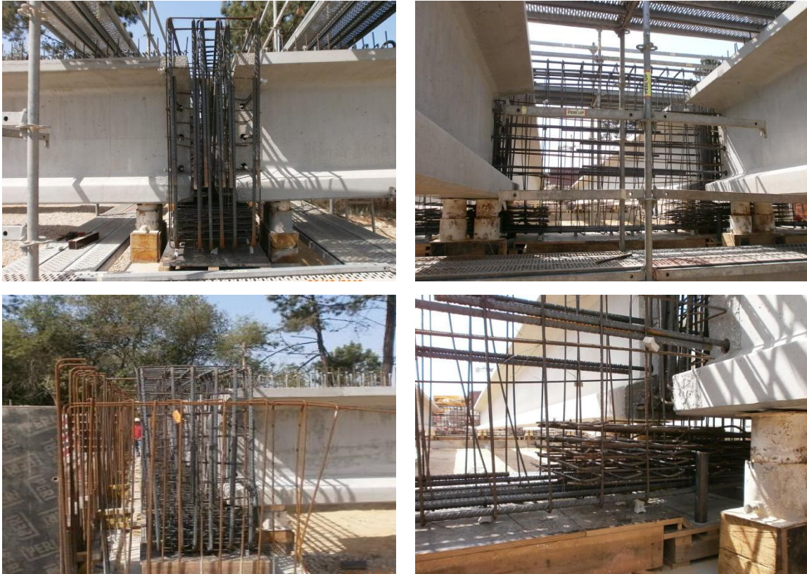
Imagem 18 - Armadura da carlinga em alinhamento de pilares (imagens superiores), e do encontro (imagem inferior esquerda) e reforço de armadura na zona de apoio das vigas (imagem inferior direita)
